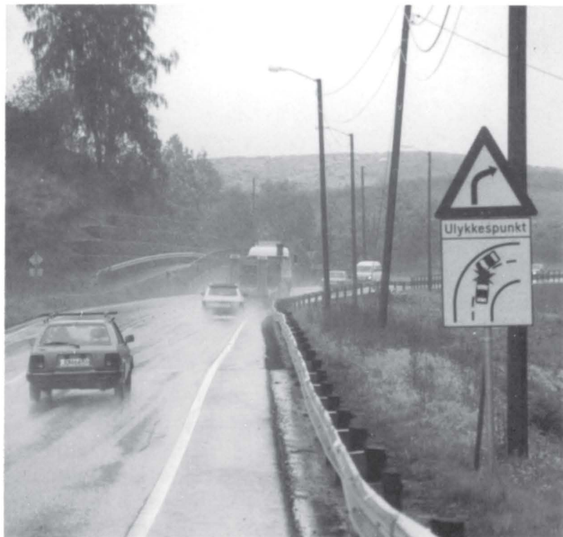
Stein Erichsrud peker på at veg- og terrengforholdene som utslagsgivende for at Foss bru har blitt et så sterkt belastet ulykkespunkt.
