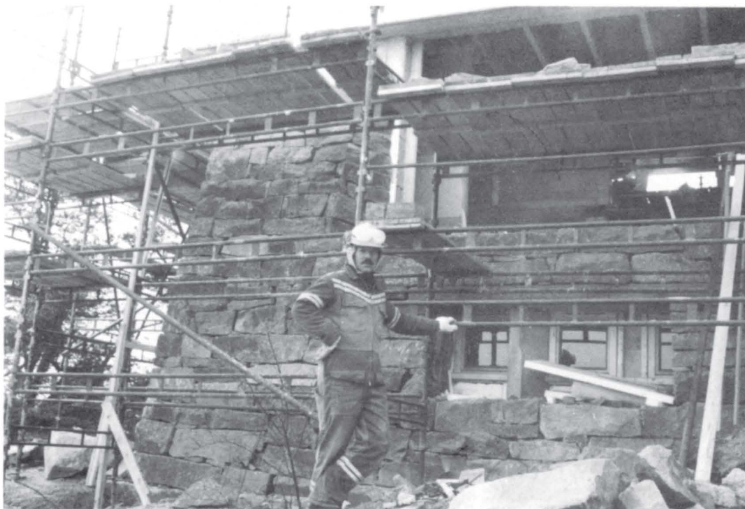
Hoffmurer Arvid Reigstad fra Statens vegvesen Hordaland igang med tørruren på fritidsboligen til kongeparet på Tjøme.
