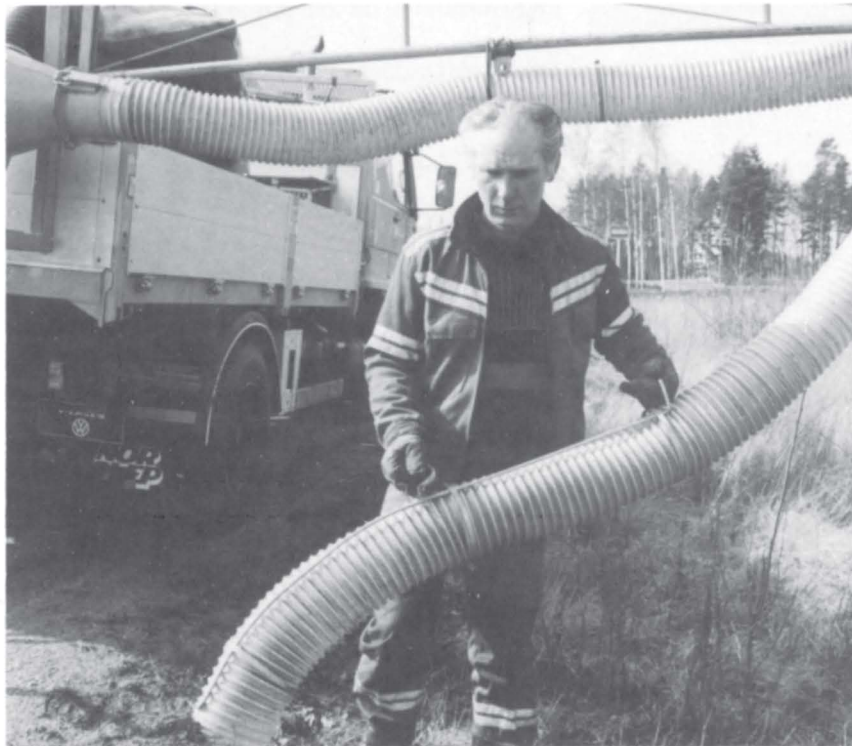
Søppelsugeren som maskinavdelingen utviklet, er et godt eksempel på vellykket FoU-arbeid som gir bedre arbeidsmiljø og økonomisk gevinst. Her ser vi Gunnar Svendsen fra område 3 igang med sugeren.
