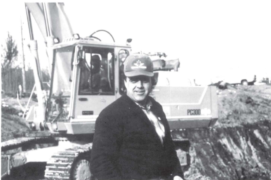
Arbeidet med Sydoverveien er i full gang og Vidar Rehn har det daglige ansvaret for legging av kabler. Her ser vi han sammen med Åge Nilsen (i bakgrunnen).
