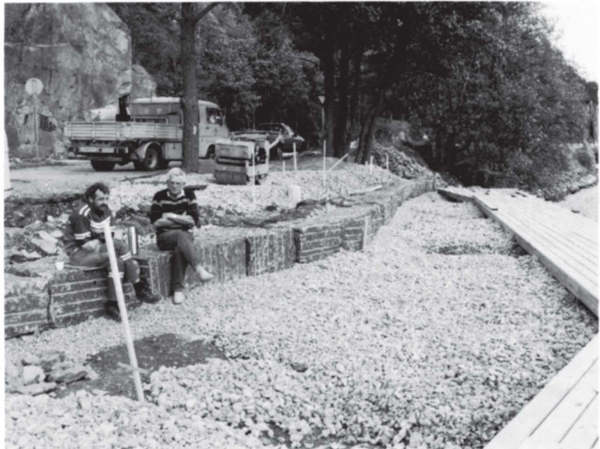
Rasteplassen ved Halle vannet får flott beliggenhet og er godt miljøtilpasset.
