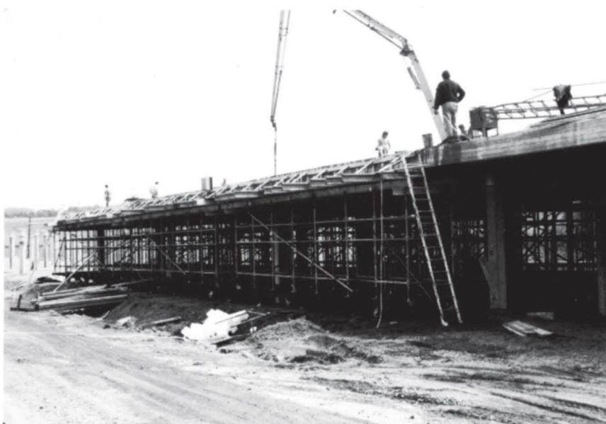
Støping har pågått i hele sommer på pælebrua over Gjenne- stadmyra. Arbeidet vil bli avsluttet i august.
