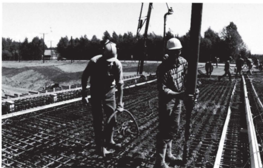
Egenregikalkylen Furulund bru på E 18-anlegget er nå støpt ferdig
