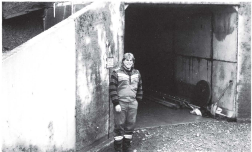
Forlengelsen av kulverten i Undrumsdal er Per Olav Vierøds praktiske fagprøve.
