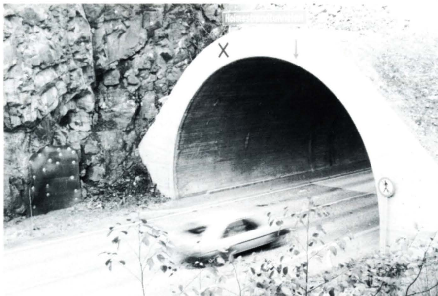
Vegstøvet fra tunnelen må deponeres i god avstand fra vannkilder.
