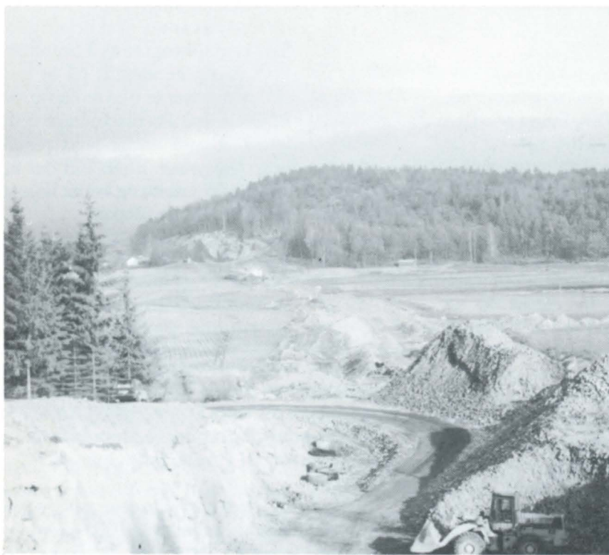
Arbeidet med E 18 i Stokke går så fort fram at det vil være teknisk mulig å åpne tidligere enn 2. juli 1992. Her fra skjæringen ved Asketraet.
