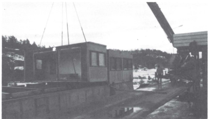
19. desember ble de gamle brakkeene heist på plass på sitt nye fundament på utsiden av Solum-vekta
