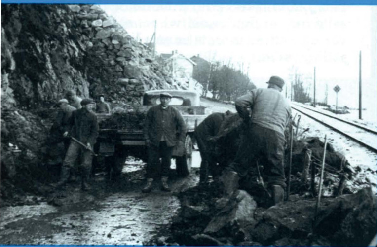
Rydding etter ras på E 18 ved Tvillingbru, Holmestrand, mars 1958. Legg merke til vegstandarden og at håndkraft fortsatt brukes.
