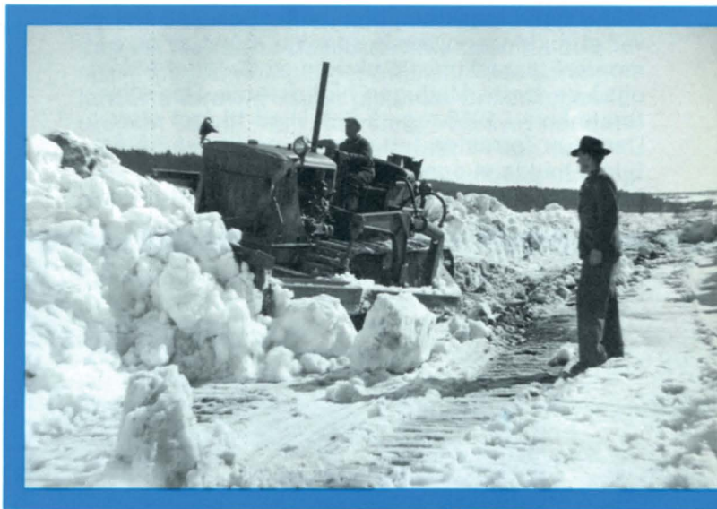
Den første bulldozeren i aksjon med snørydding på E 18-anlegget på Hemsengen 1951.
