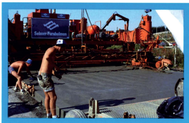
Vegdekket på parsellen Gulli-Holmene skal kunne ligge i 15 år uten vedlikehold.
