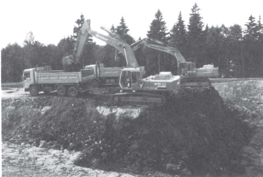
I løpet av perioden 8 august - 4. september ble det gravd ut og kjørt bort ca. 76.000 kbm eller 10.000 lass med løsmasser i området ved Flykaféen
