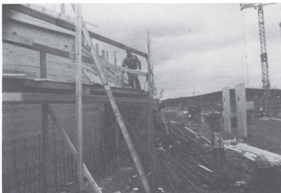
På Hesby er arbeidet med brua for Andebuvegen kommet godt i gang.
