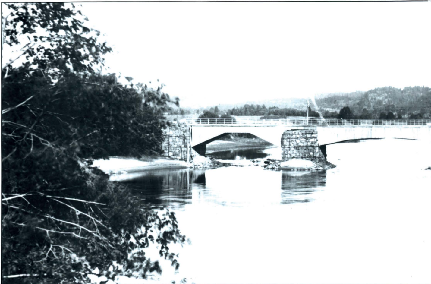
Den første brua over Lågen ved Bommestad ble bygd omkring 1808 og var i bruk til 1902. De siste 50 åra var utgravninger omkring pillarene og råte et nærmest konstant problem. Brustedet ved Bommestad var (og er?) det viktigste i fylket.
