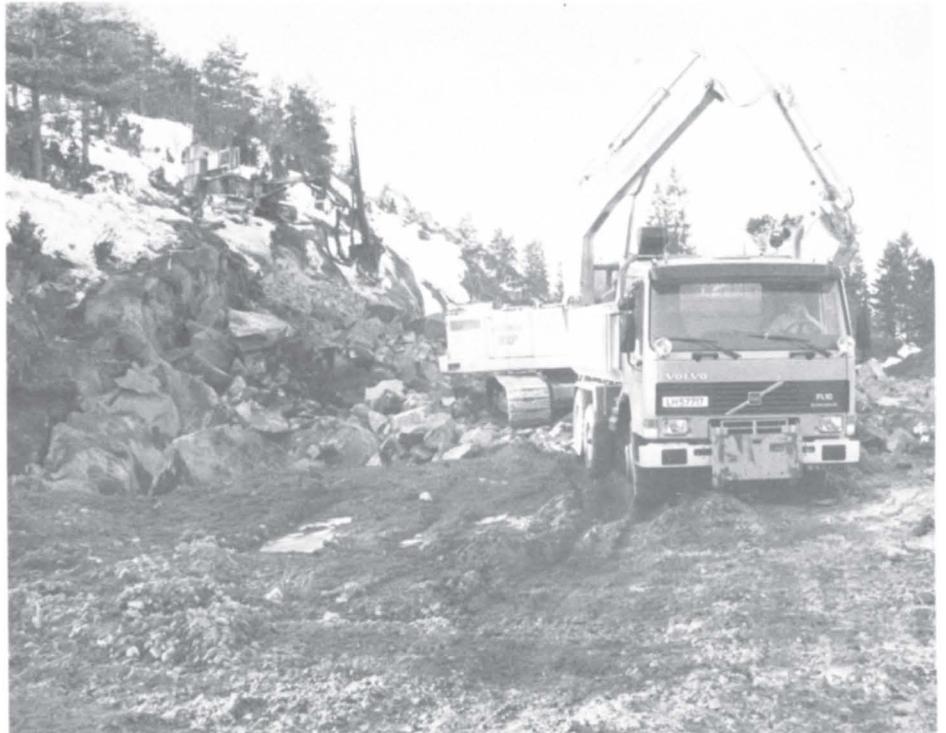
I Holmenåsen er arbeidene med å sprengne ut flere tusen kubikkmeter fjell startet. Steinmassene pukkes og brukes andre steder på anlegget.
