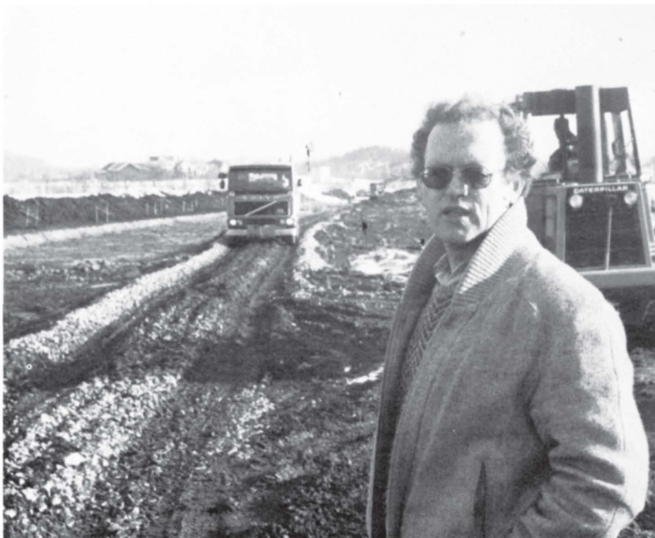
Oppsynsmann Georg Johnsen er godt i gang med den nye E-18 forbi Sem. Her er arbeidene i gang på en strekning mot Aulielva. Veien bygges ferdig slik at utstyr og materiell til bygging av brua kan bringes fram. På den måten spares utgiftene til dyre interimsveier.
