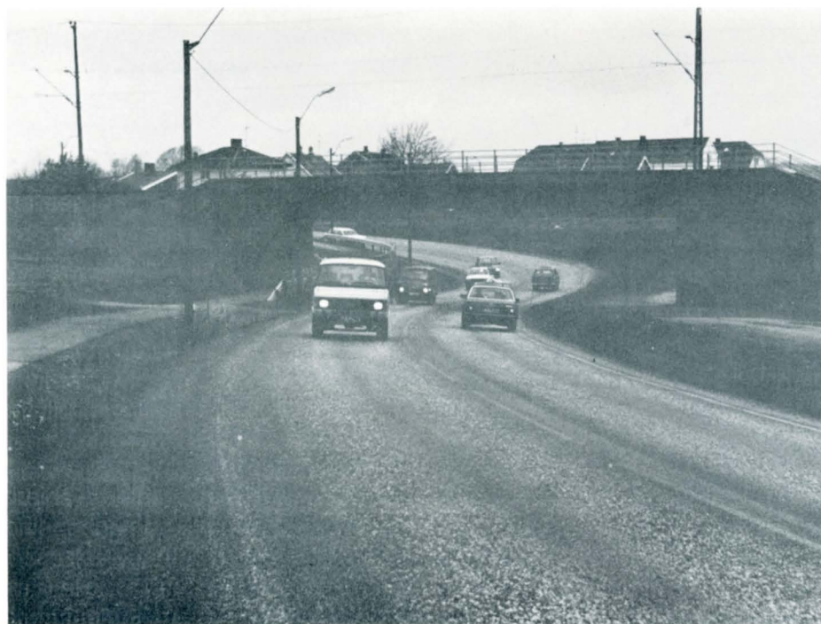
Auliundergangen har blitt 3,3 mill. kr. dyrere enn forutsatt i konsulentens kostnadsoverslag. Plan- og anleggsavdelingen har nå gått gjennom prosjektet for å finne årsaken til overskridelsen.
