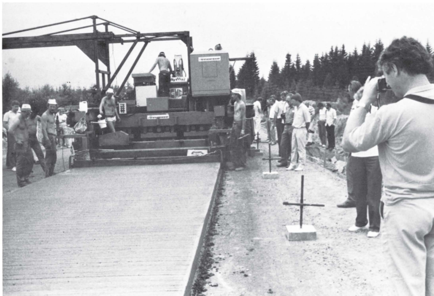
Det ble også tid til å se på betongutleggeren. Her legges det nærmere 400 m 20 cm tykt betongdekke i en bredde på 3,25 m hver dag.
