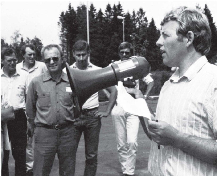
Anleggsleder Gunnar Hasle orienterte om E-18-anlegget og det spesielle betongdekket som nå blir lagt.
