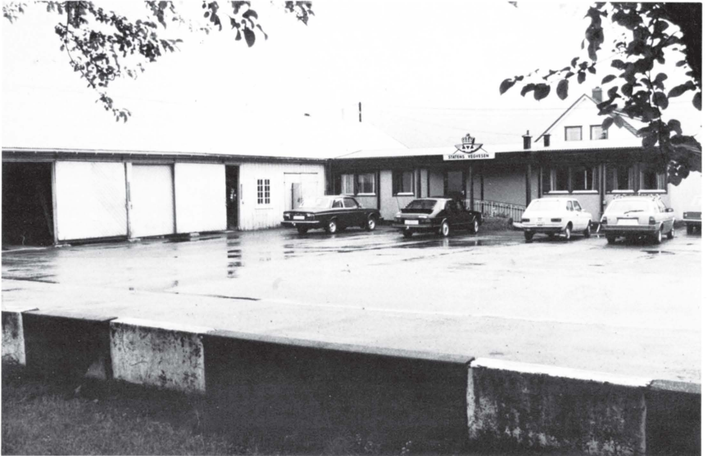
Vedlikeholdsområde 1 er nå det eneste område som fortsatt må leve med dårlig forhold på vegstasjonen. I Sande er fortsatt brakketilværelsen et faktum.
