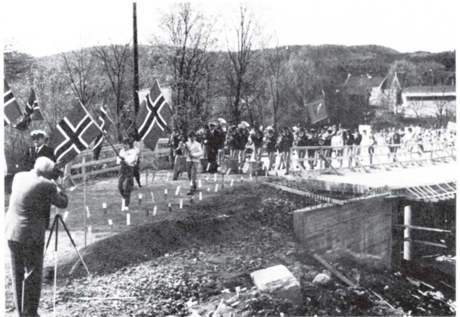
17. mai toget i Sande gikk som vanlig over Haga bru selv om betongdekket bare var et par dager gammelt.
