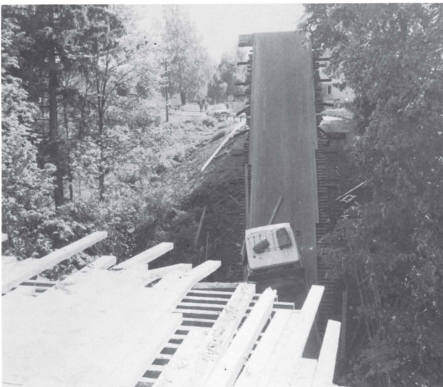
En av de alvorlige ulykkene i første halvår var at Haga bru brøt sammen under en trailer natt til 30. mai. Brua ble totalskadet, men heldigvis var det ingen personskader.
