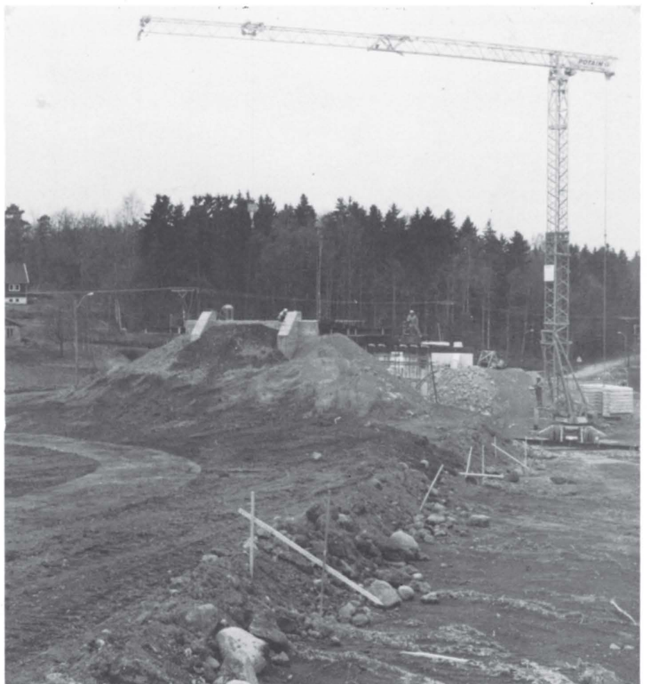
Ny E-18 Klinestad - Tassebekk er det største anlegget i 1985. Her ved Hørdalen bru bygges fylkesvegen over den nye europavegen.
