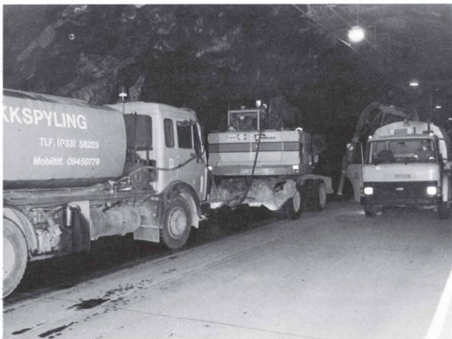
Det blir hektisk aktivitet når E-18 tunnelen i Holmestrand skal ha sin årlige storsjekk.
