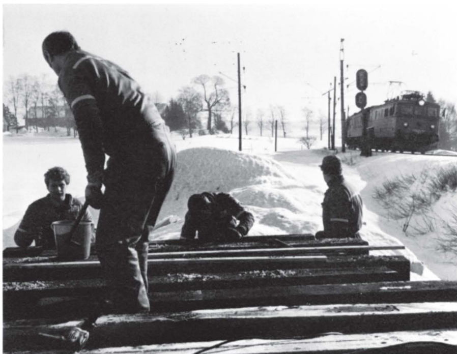
Våre arbeidsfolk på anlegget har nå også prøvd seg som jernbanearbeidere. Her er fra venstre Henk Samnøy, Thorleif Eriksen, Thor Opsahl og Sverre Larsen i gang med å legge ut jernbanesviller.
