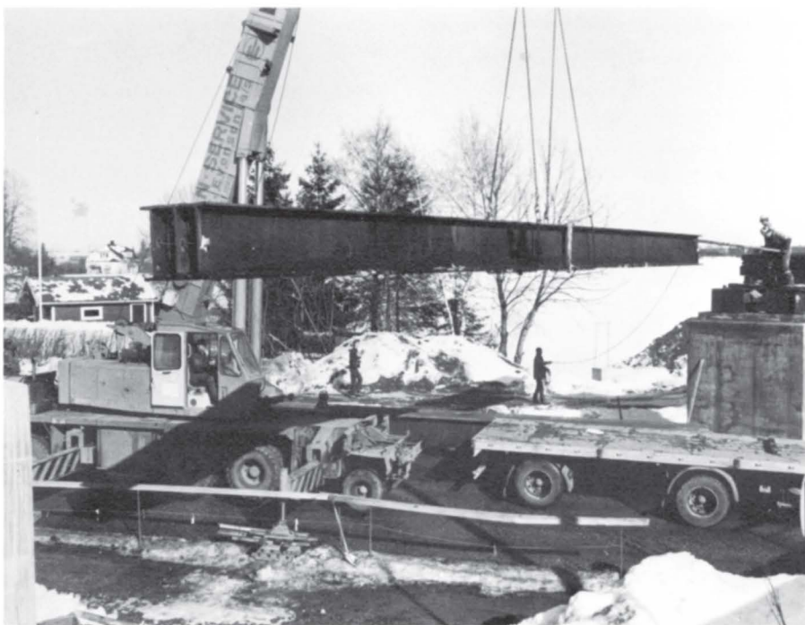
Det er ikke lenger noe stort problem å få på plass store og tunge jernbjelker. Mobilkrana manøvrerer den 20 meter lange og 20 tonn tunge jernbjelke som om den nesten ikke skulle veie noe i det hele tatt. Operasjonen tok bare et par minutter pr. bjelke. Det er klargjøring og tilrigging som tar det meste av tiden.
