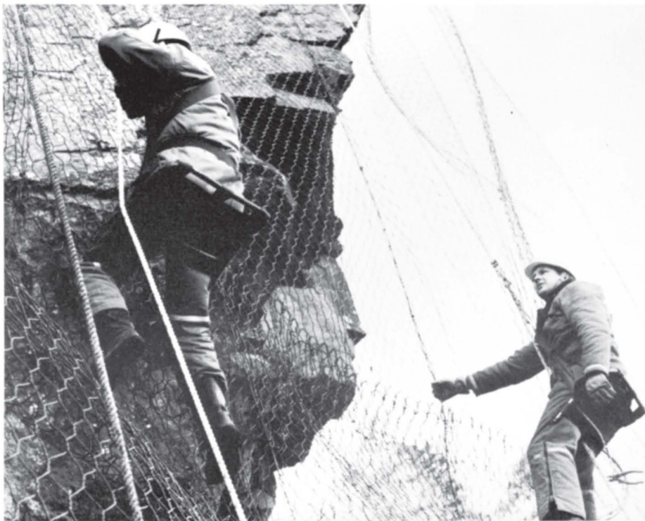
Dyktige og innsatsvillige mannskaper var en av hovedgrunnene til at vi kostnadmessig kom svært godt ut i arbeidet med sikring av Storsvensken ifjor høst. Her er Magne Stenbrenden og Sigbjørn Gjenden i gang med å sy nettene sammen langt nede i fjellveggen.
