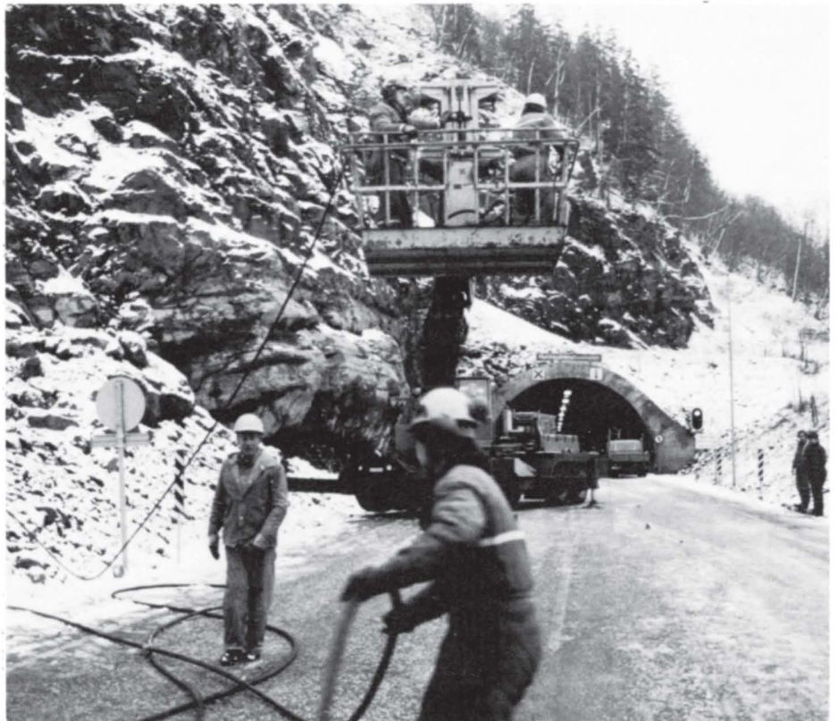
Igjen måtte mannskaper fra vedlikeholdsområde 1 rykke ut for å utføre renskningsarbeid i fjellet langs E-18. Her er Kurt Sommervik og Adolf Akerholdt i gang med å legge ut trykkluftsslanger.
