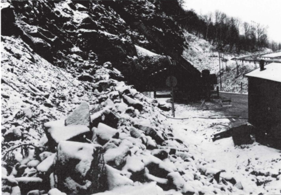
Steinvollen som er lagt opp langs E-18 syd for tunnelen gjorde jobben denne gangen. Det aller meste av raset som gikk julaften ble stoppet og bare noen enkelte steiner kom ut i vegkanten.
