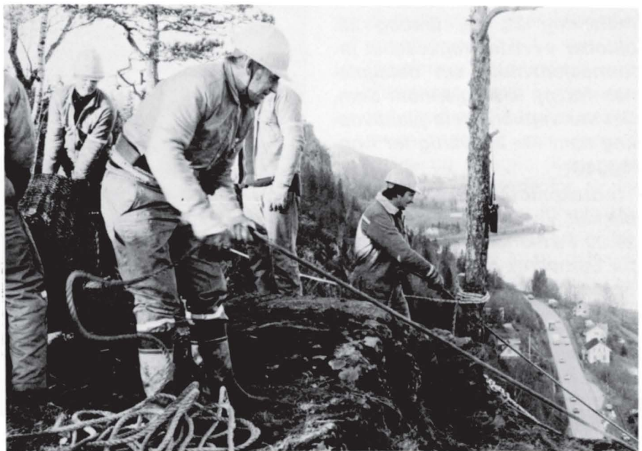
Størstedelen av arbeidet foregikk ved å fire utstyr ned fra toppen av fjellet. Her krevdes det stor nøyaktighet da all kommunikasjon foregikk via walkie-talkie. Her er Adolf Akerholt og Magne Stenbrenden i ferd med å fire et nytt nett ned i fjellveggen.
