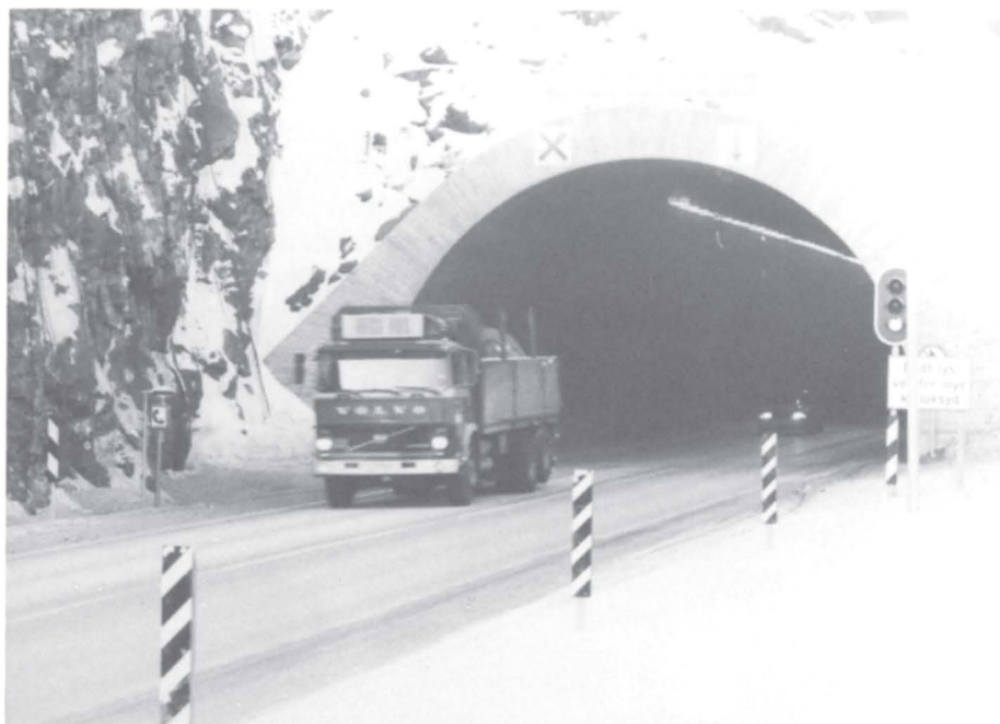
Vedlikeholdet av Holmestrandtunnelen vil koste ca. 1/2 million kroner eller ca. 270 kroner pr. meter tunnel i 1984.
