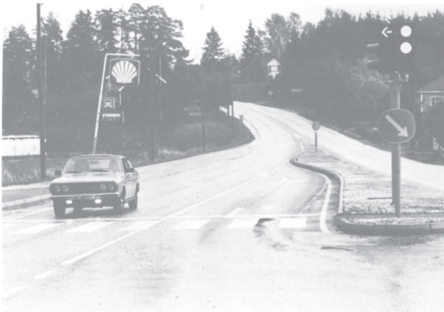
Lyssignalene i det nye anlegget i krysset veg Jarlsberg vertshus er det eneste lavspenntanlegget i Vestfold hittil.
