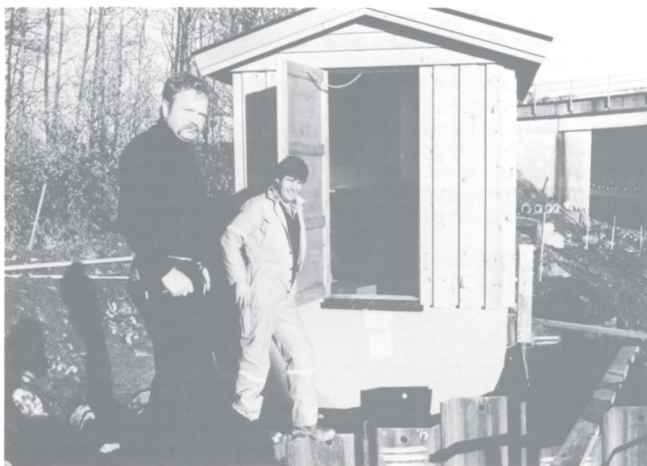
Oppsynsmann Eivind Holtan og Helge Sogn foran hytta hvor pumpeanlegget er plassert.
