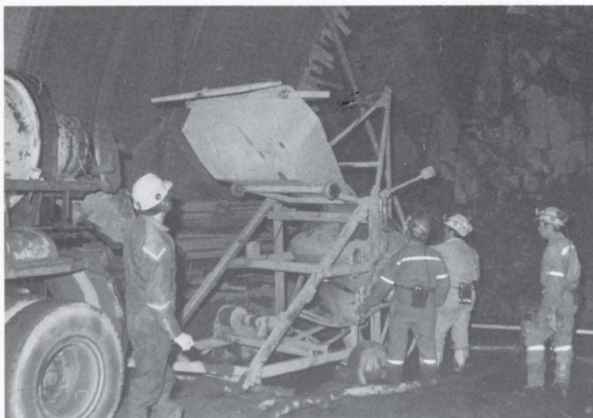
Støping på stoff.
