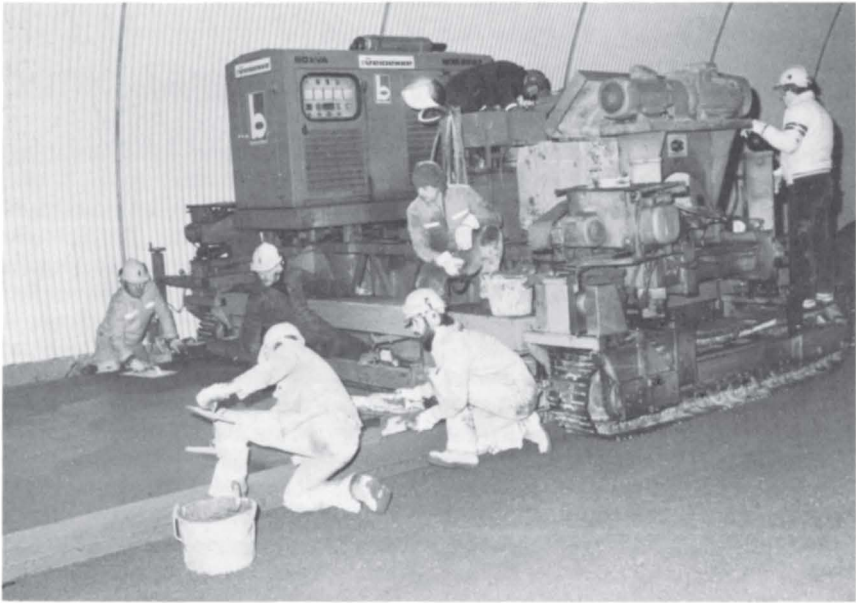
Støping av betongdekke.
