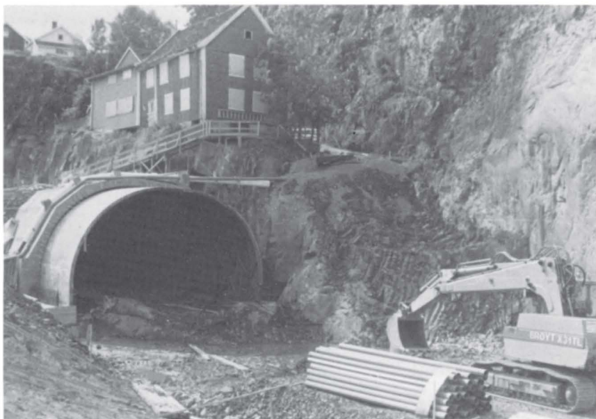
Tunnelinngangen i nord.
