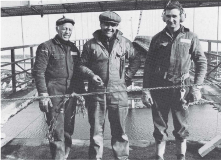
Da vi besøkte brua var 3 av karene til Alfr. Andersen i gang med rivingsarbeider. Fra venstre ser vi Markus Borgersen, Terje Aas og Louis Marcellis.
