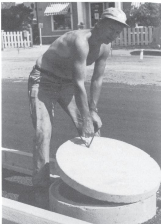
Odd M. Andersen viser lokk med fore-skrevet innstøpt håndtak.
