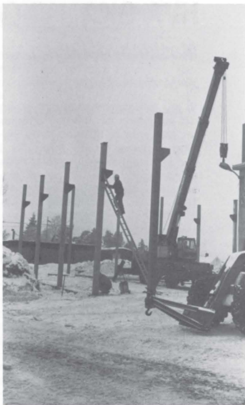
Bygging av nytt verksted på Vegsentralen i god gjenge.
