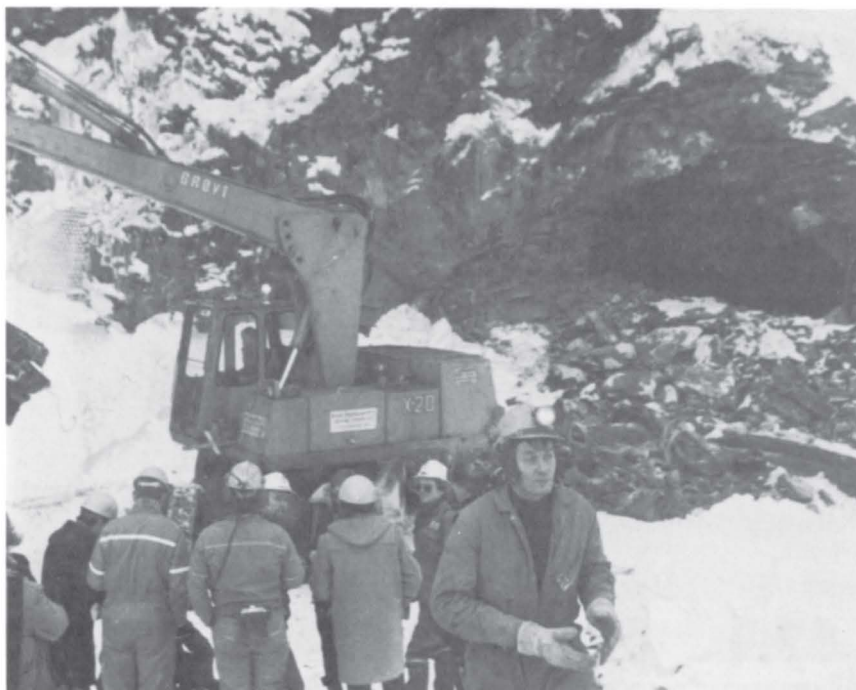
Ca. 1/3 av total tunnelprofil ble sprengt ut ved gjennomslaget. I forgunnen oppsynsmann Gunnar Gullbrå, som var førstemann ut i dagen.
