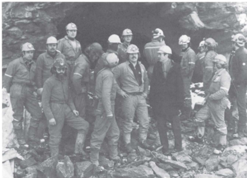
Anleggsgjengen sammen med vegsjefen i røysa.
