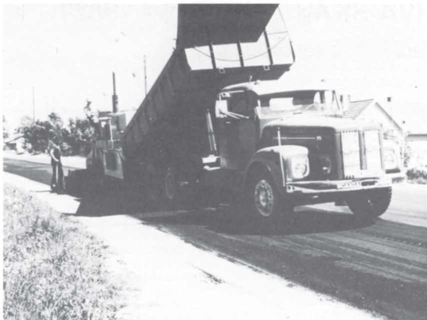
Asfaltering vil ta en stor del av vedlikeholdsmidlene i 1982.
