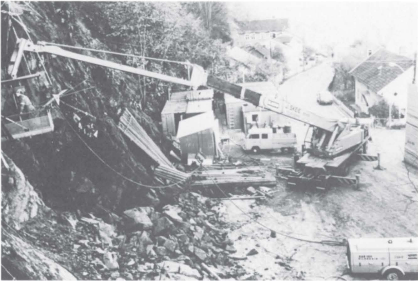
E-18 anlegget i Holmestrand blir i 1981 vårt største veganlegg.
