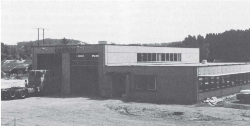
Nybygget med hovedinngang og kontrollhall med 2 løp.
