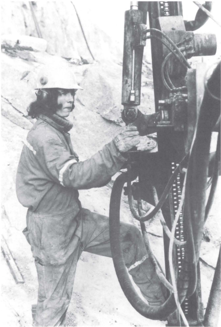
Geir Aronsen i gang med boring på Nemek borvogn.
