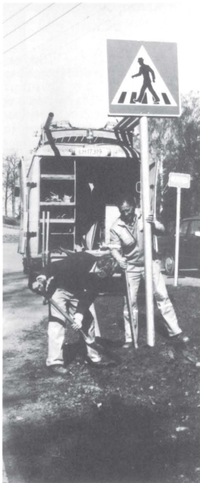
Reidar Horn til venstre og Kåre Klausen setter opp fotgjengerskilt i Slagen. (Foto: Oddvar Kristiansen)
