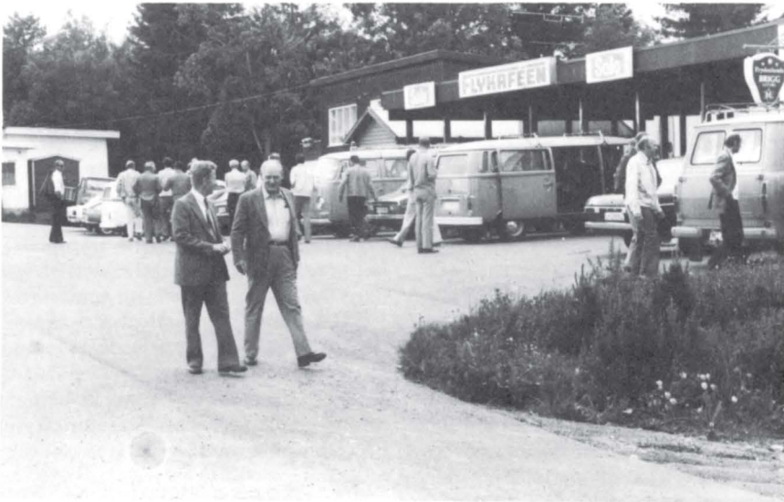
Eigeland og Dannevig diskuterer betonglegging.
