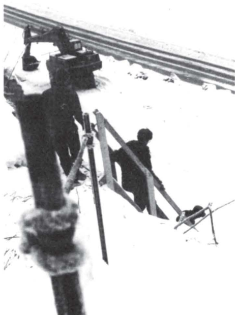
Den 8.5 m lange trappa har rekkverk på begge sider.
