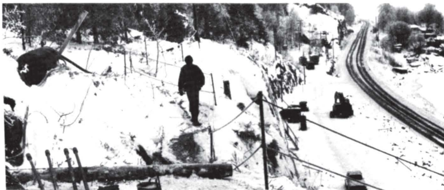
Gangvegen går langs skjæringstoppen. Den er sikret av et rekkverk bestående av 2 tau.
