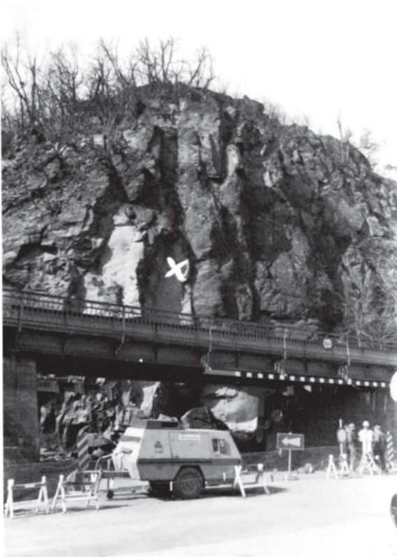
Oversiktsbilde av raset på Nyvegen.
