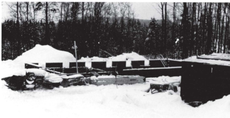
Grunnmuren til kontorbygget.
