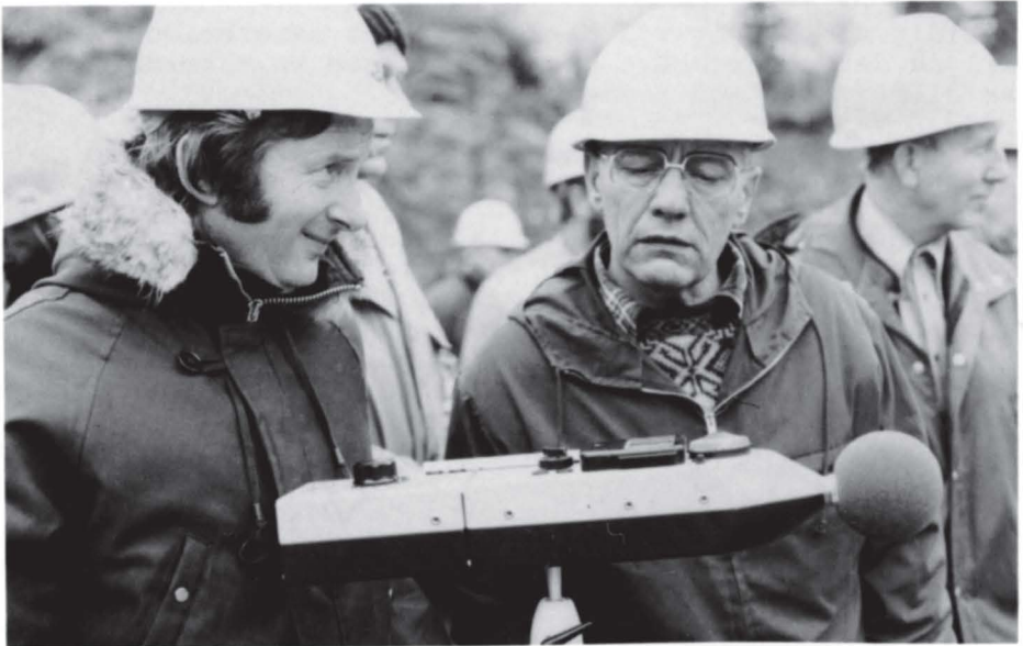
Støymåling av kompressor.
