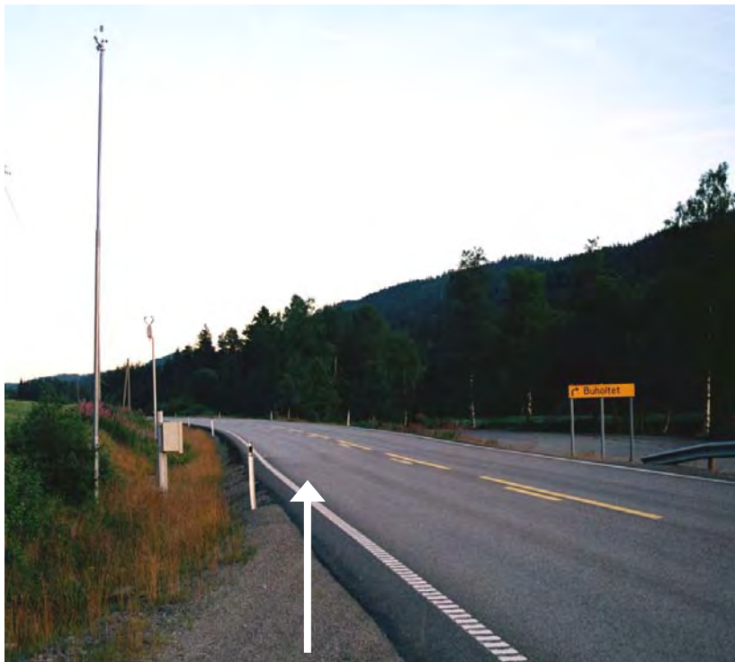
Figur 8. Vegbanetemperatursensoren monteres mellom hjulspor og vegkant.
