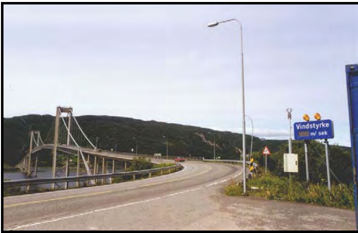
Figur 2. Eksempel på klimastasjon ved enden av en bro. Stasjonen styrer skiltet som angir vindhastighet.
