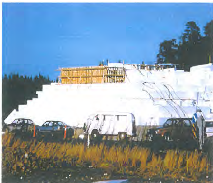
Figur 57. Forskalingsarbeid for brulandkar i EPS fylling
