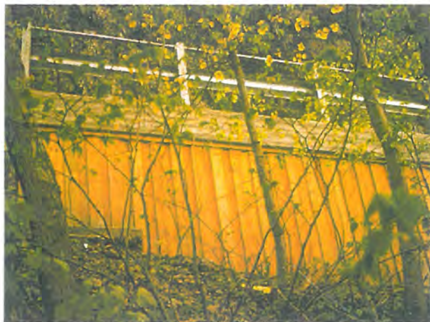
Figur 46. Rv315 Nyveien - trekledning
