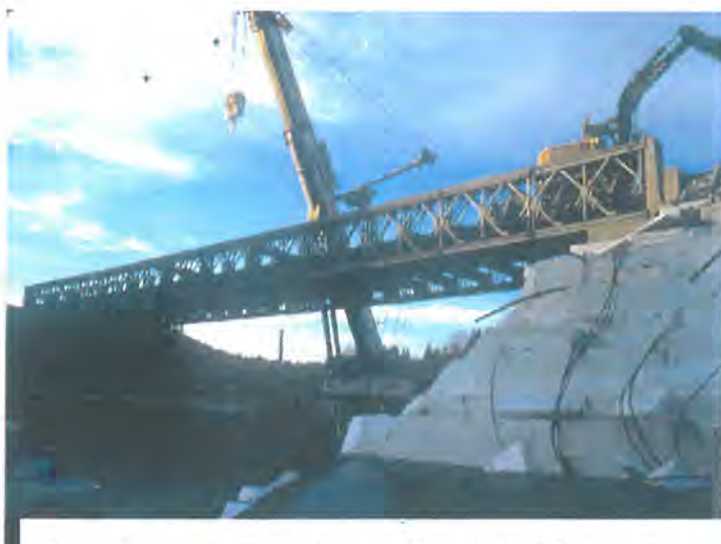
Figur 59. Acrow stålbru heises på plass på fyllingshoder av EPS
