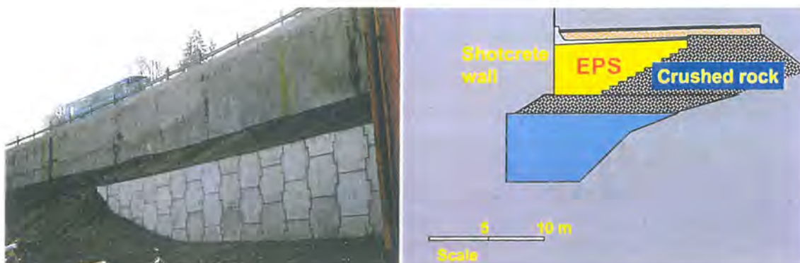
Figur 5. EPS fylling med vertikal avslutning. Eidsvoll 1993
