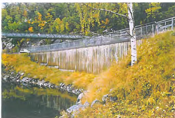
Figur 45. E6 Nesset. Frontkledning av tre
