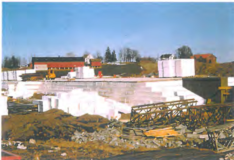
Figur 29. Oppfylling med inntil 5 m EPS inntil brulandkar
