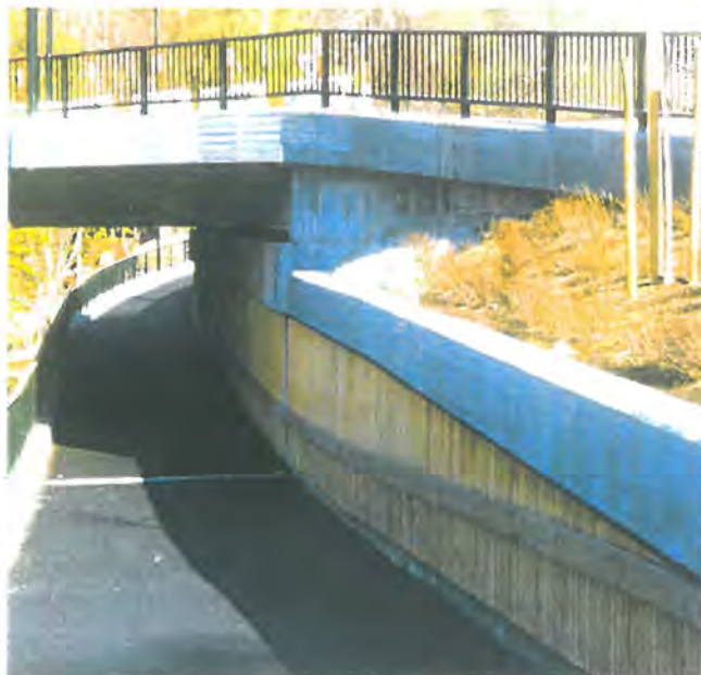
Figur 49. Arendal Øst- vest. Trekledning foran EPS fylling
