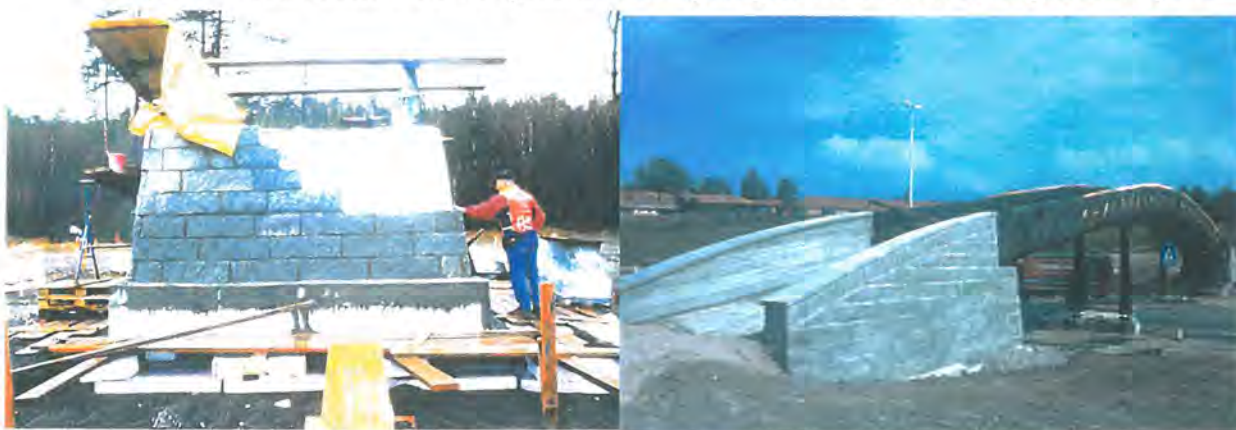
Figur 71 Rv 109 Rolvsøyvegen. Gangbruer fundamentert på EPS
