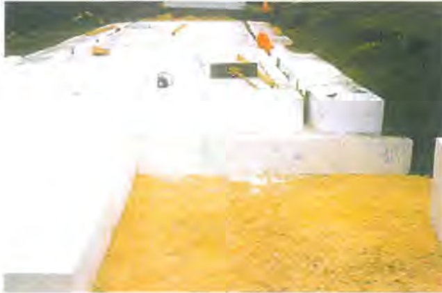
Figur 33. Rv 610 Utlegging av EPS på trau av sagflis
