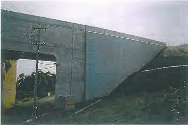
Figur 6. Akagawa Bridge i Japan. Verdens høyeste vertikale EPS fylling.
