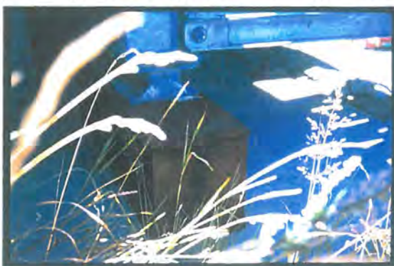
Figur 61. Jekking av Løkkeberg bru
