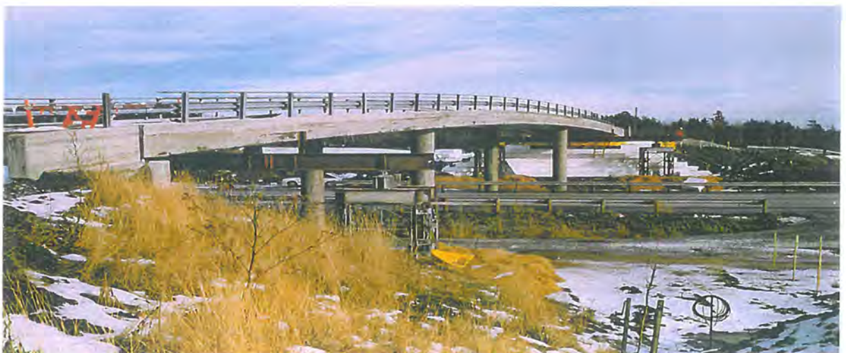
Figur 68. Oppbygging av EPS-fyllinger. Brua bæres av midlertidige understøttelser.
