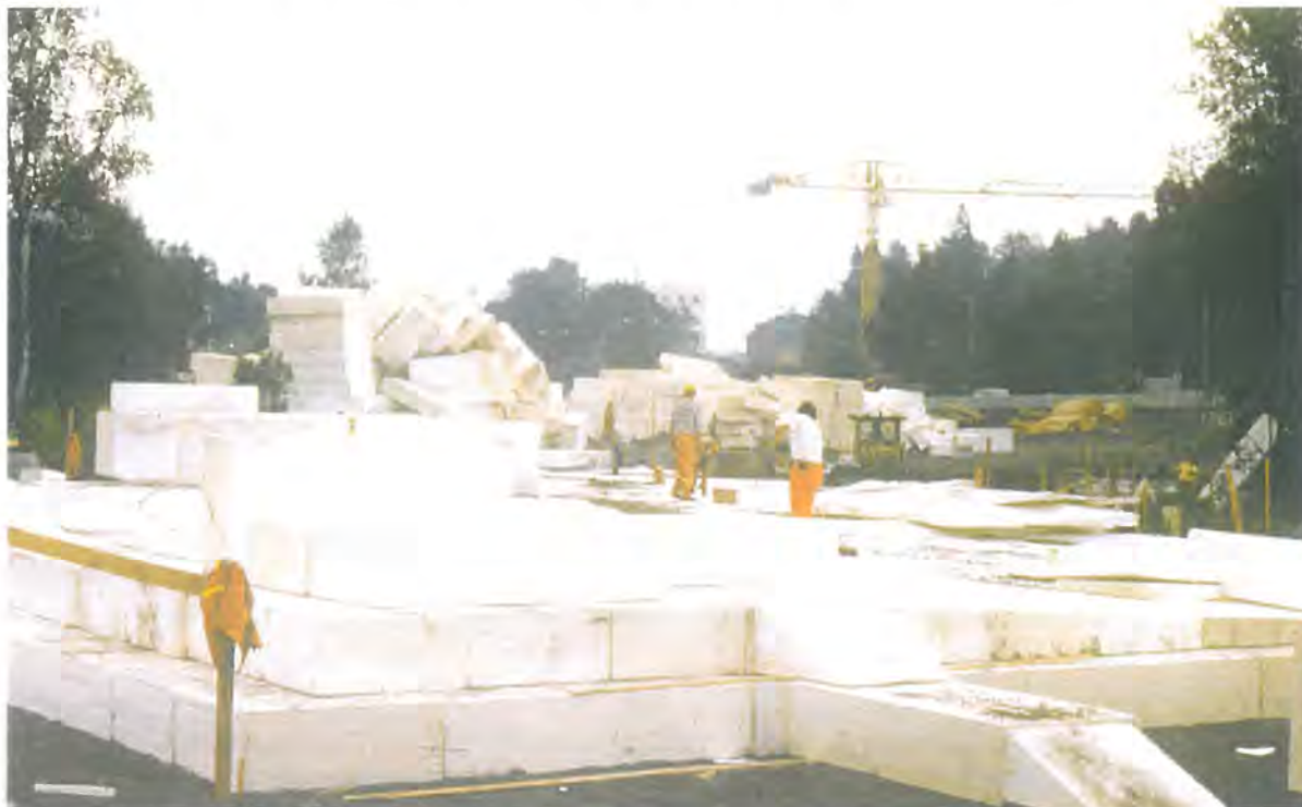
Figur 16. Lysakerkrysset – utlegging av EPS.
