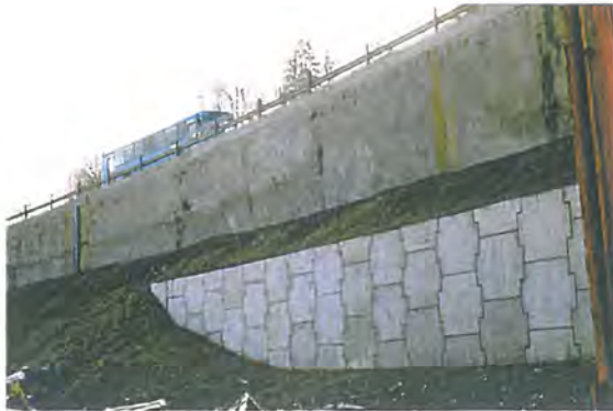
Figur 44. Kombinert EPS og Reinforced earth vegg
