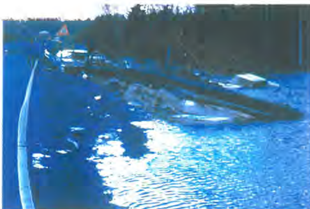
Figur 13. RV 159 Flom bruer. Oppdrift av EPS blokker pga. flom
