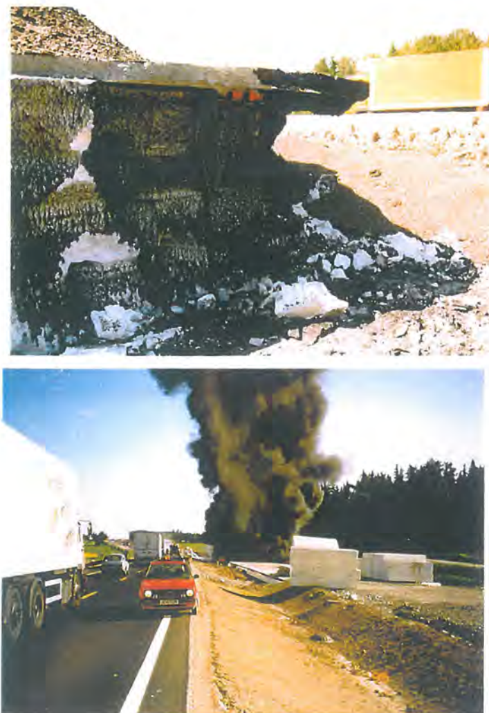
Figur 14. Antenning av EPS fyllinger. E6 Vestby 1995
