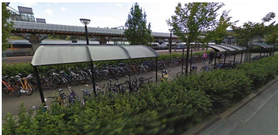
Figur 17 Sykkelparkering Asker stasjon. Foto: Google maps
