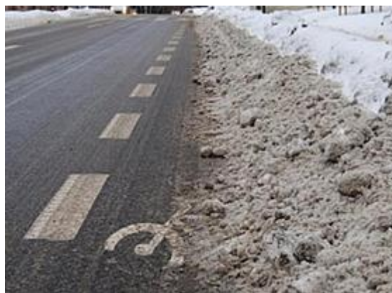
Figur 32: Dårlig brøyting gjør det vanskelig å sykle om vinteren. Foto: M. Sørensen
