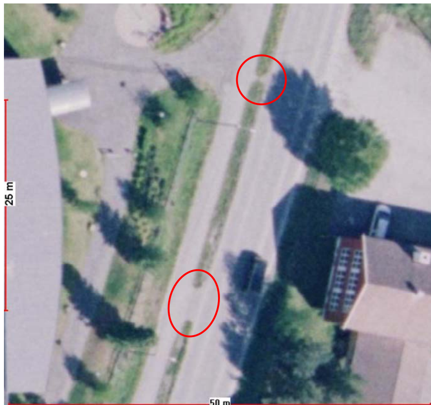
Bilde 4: Hull i barriere, sommer
