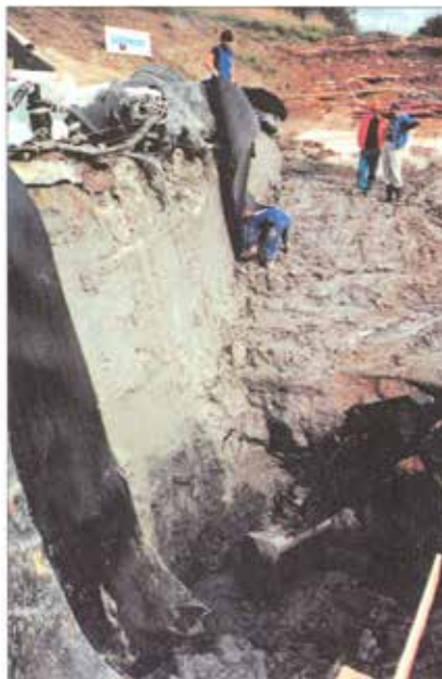
Figur 1-10-6 Utgraving for midlertidig støttevegg. (foto: A L Berggren)
