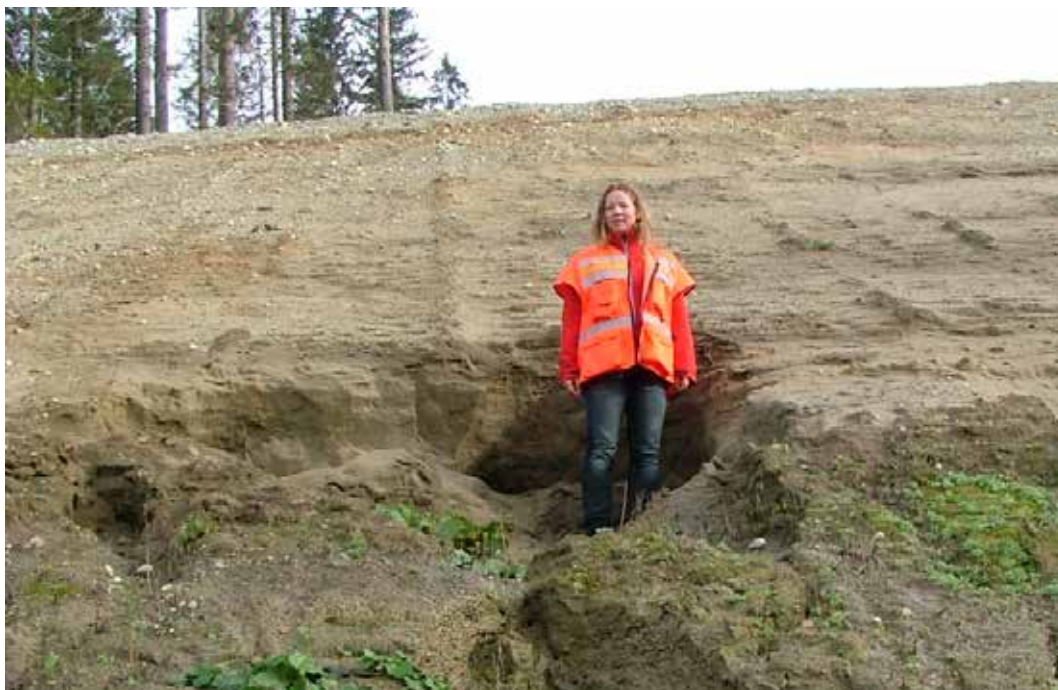
Figur 3-1- 7 Eksempel på grunnvannserosjon (Foto: Thorbjørn Hansen, Region øst).
