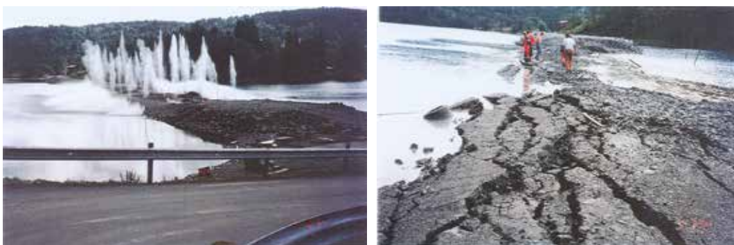
Figur 1-3- 7 Eksempel på ettersprengning av fylling lagt ut med Flekkefjordmetoden (Foto: Frestad/Pedersen)
