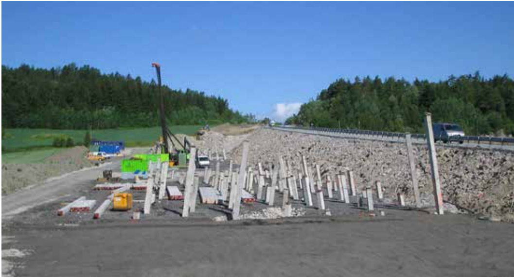
Figur 1-5- 17 Ramming av betongpeler for E6 Svingenskogen–Solberg, Østfold (foto: Yngvar Hanson)
