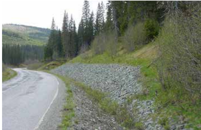
Figur 3-1- 26 Masseutskifting i skråningsfot (Gartland i Nord-Trøndelag, Foto: Kjell Eriksen).
