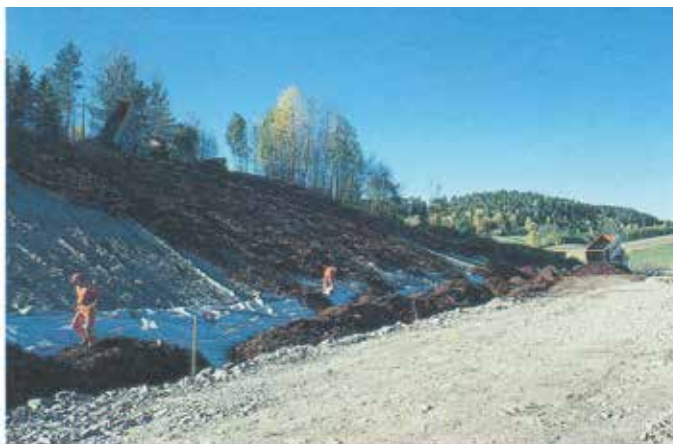
Figur 3-1- 23 Legging av barkoverflate på siltskråning ved rv 36 i Telemark sommeren 1984, (Foto: Birger Aase).
