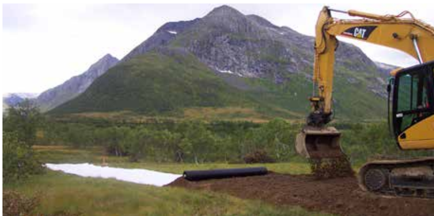
Figur 1-4- 24 Anleggsveg i forbindelse med bygging av LoFast (Foto: Roald Aabøe)
