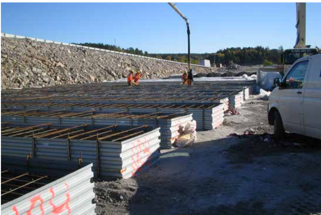
Figur 1-5- 18 Støping av betongstriper over peler (foto: Yngvar Hanson)
