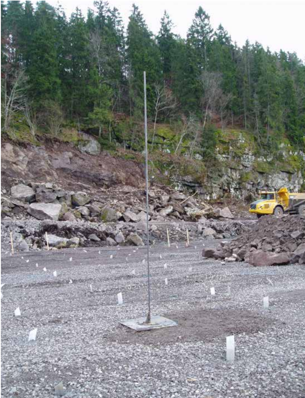
Figur 1-6-9 Bildet viser installasjon av tradisjonell setningsmåler med plate og stang. Platen plasseres på grusputen/drenslaget, og beskyttes med et stålrør som fylles med grus. (E18 Kopstad – Gulli 2004 – Foto: C.E. Dahl)
