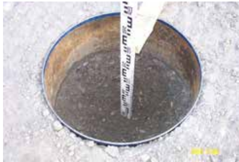
Figur 2-4- 27 Prøvetaking av komprimert skumglass (Foto: Kjell Eriksen, Statens vegvesen)
