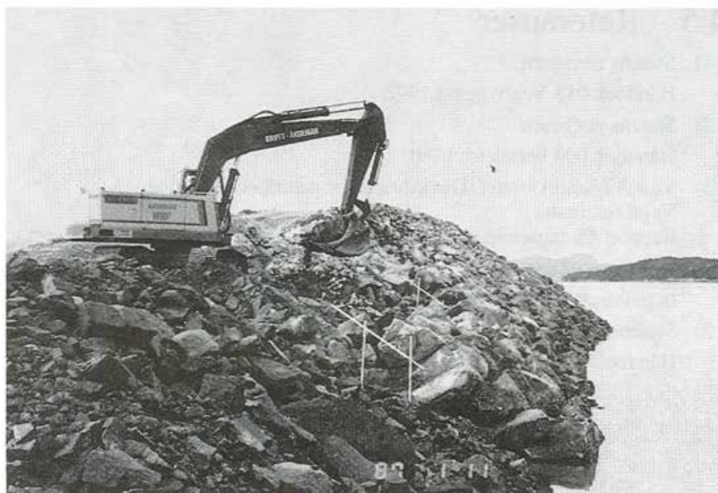
Figur 3-3- 29 Utlegging av steinplastring (Foto: O. Pladsen).
