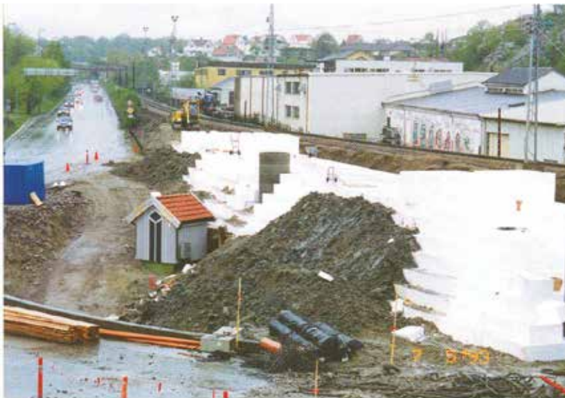
Figur 2-4- 8 EPS-fylling for jernbane (Foto: K.Brattoang, Statens vegvesen Østfold)
