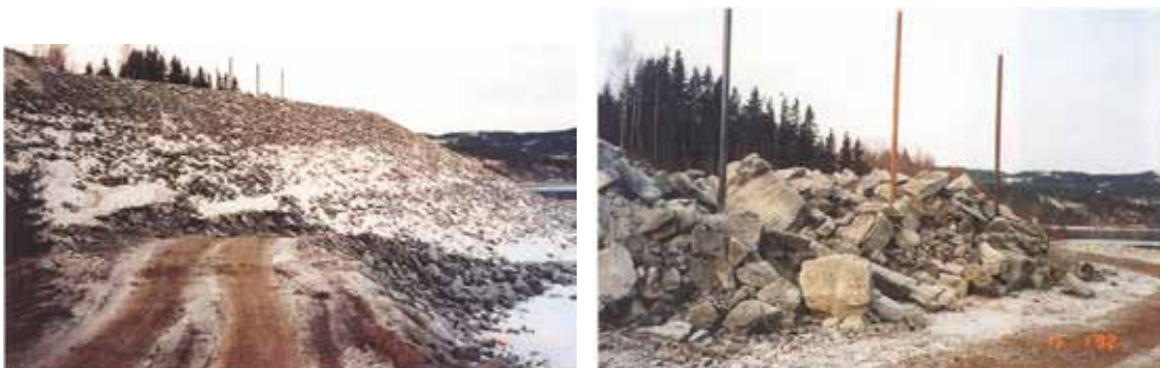
Figur 2-3-7 Fylling for bruhode med setningsmålere der forbelastning delvis er lagt ut. Setninger måles ved nivellering av topp rør. (Foto: Nils Rygg, Veglaboratoriet)
