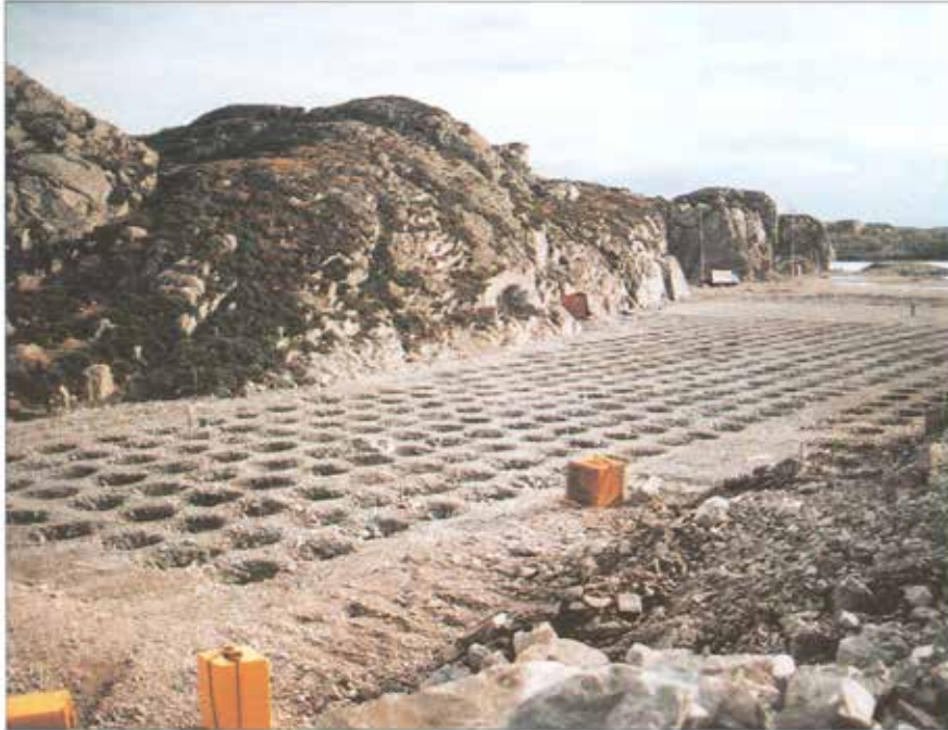
Figur 1-11-2 Dypkomprimering, Kollsnes. (Foto: Noteby)
