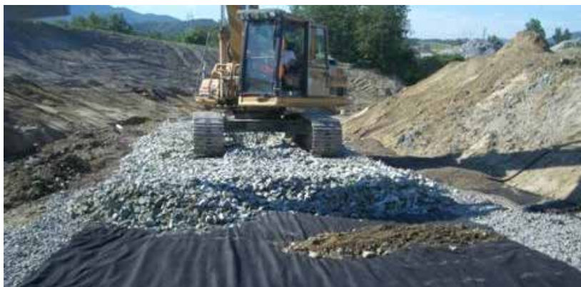
Figur 2-4- 24 Utlegging og komprimering av skumglass med lett gravemaskin(Foto: Melhusprosjektet).
