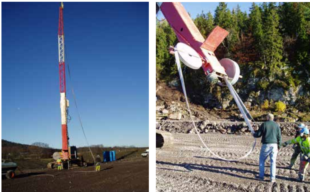
Figur 1-6- 8 Bildet viser rigg og rullen med vertikal dren montert. Legg merke til vannslangen som er koblet til riggen for spyling av stikkeren. (E18 Kopstad – Gulli 2004 – Foto: C.E. Dahl)
