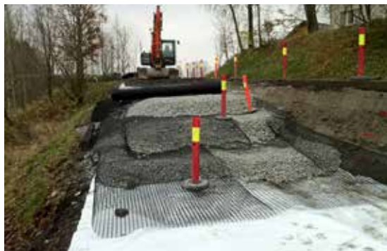
Figur 1-4-28 Utlagt skumglass med fiberduk og armeringsnett (Foto Jan Vaslestad).
