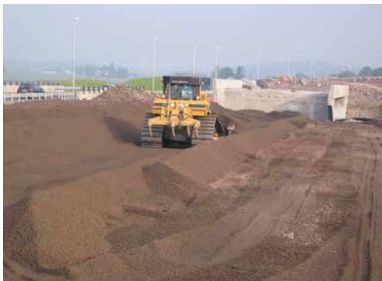
Figur 2-4- 4 Utlegging av lettklinkerfylling for E18 ved Gulli (Foto: Jon Hauge)
