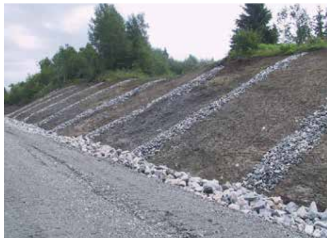
Figur 3-1-20 Skråningsdren vinkelrett på veggrøft (Rv 120, Nannestad. Foto: Arvid Sagbakken).
