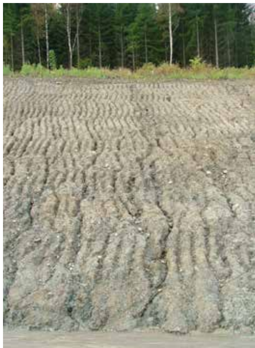
Figur 3-1- 6 Eksempel på overflateerosjon (Foto: Kristine Flesjø, Vegdirektoratet).
