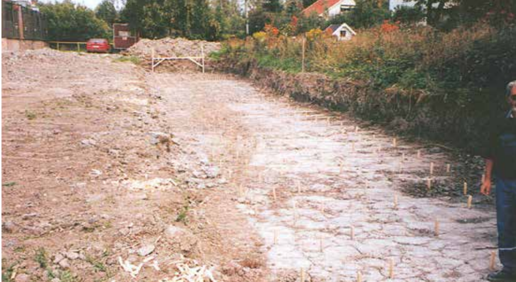
Figur 1-7-9 Bildet viser ryddet areal hvor hardt topplag er gravd ut og pele-punktene markert med plugger (Foto: Statens vegvesen)
