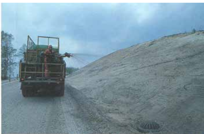
Figur 3-1- 25 Tilsåing med sprøytevogn direkte på skråningsoverflaten, (Foto: Birger Aase).
