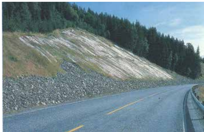
Figur 3-1- 22 Skråning i siltig morenemasse ved E76 i Morgedal. Partiet er et av de første forsøk med Eronet, utført i 1982. Skråningen har bare hatt helt ubetydelige skader etter sikringen, (Foto: Birger Aase).
