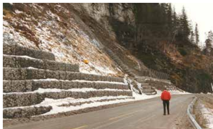
Figur 3-2- 10 Sikring av rasskråning i ur med gabioner og ubåtnett på Rv 715 ved Løften. Fanggjerde på topp av gabionmur for å sikre mot steinsprang (Foto: O.P.Wangen).
