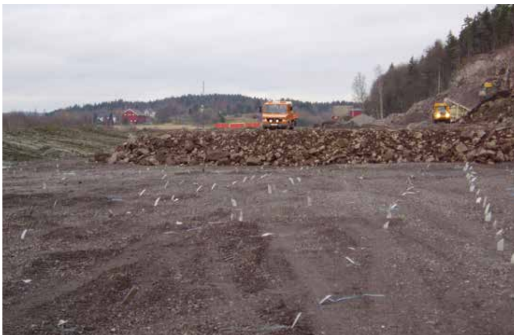
Figur 1-6- 11 Bildet viser installerte vertikaldren hvor oppfyllingen og forbelastningen kommer fortløpende etter. (E18 Kopstad – Gulli 2004 – foto C.E. Dahl)
