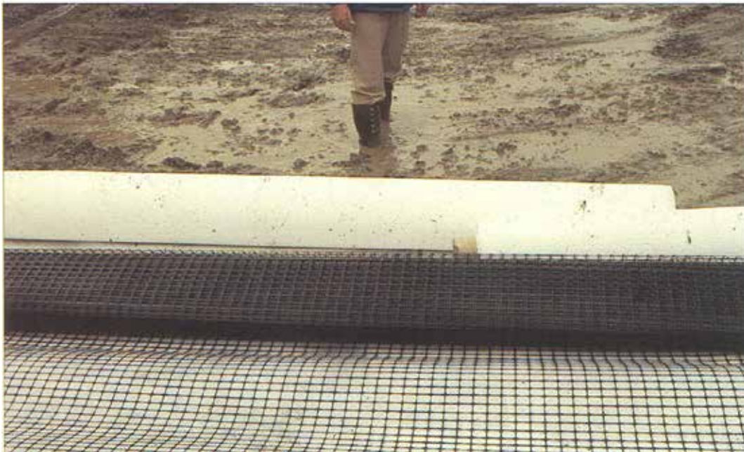
Figur 1-4-3 Utlegging av armeringsnett med underliggende fiberduk.
