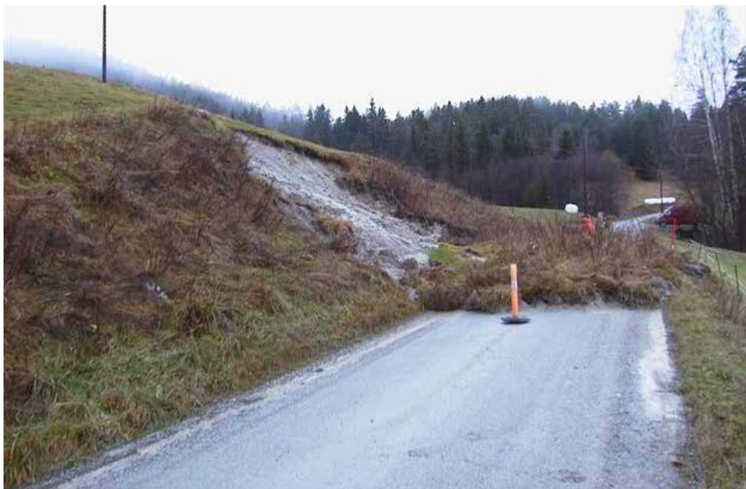
Figur 3-1- 8 Eksempel på overflateglidning (Foto: Bjørn K. Dolva, Region sør).
