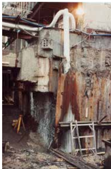
Figur 1-10-7 Stabilisering av leire under kabalkanal i spuntåpning, Oslo (Foto A-L Berggren)
