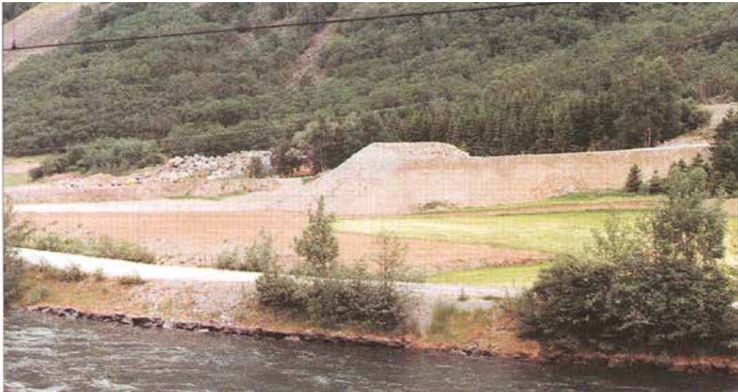
Figur 1-1- 7 Tilløpsfylling, med forbelastning, for Brekke bru i Flåm (Foto: Frode Oset).
