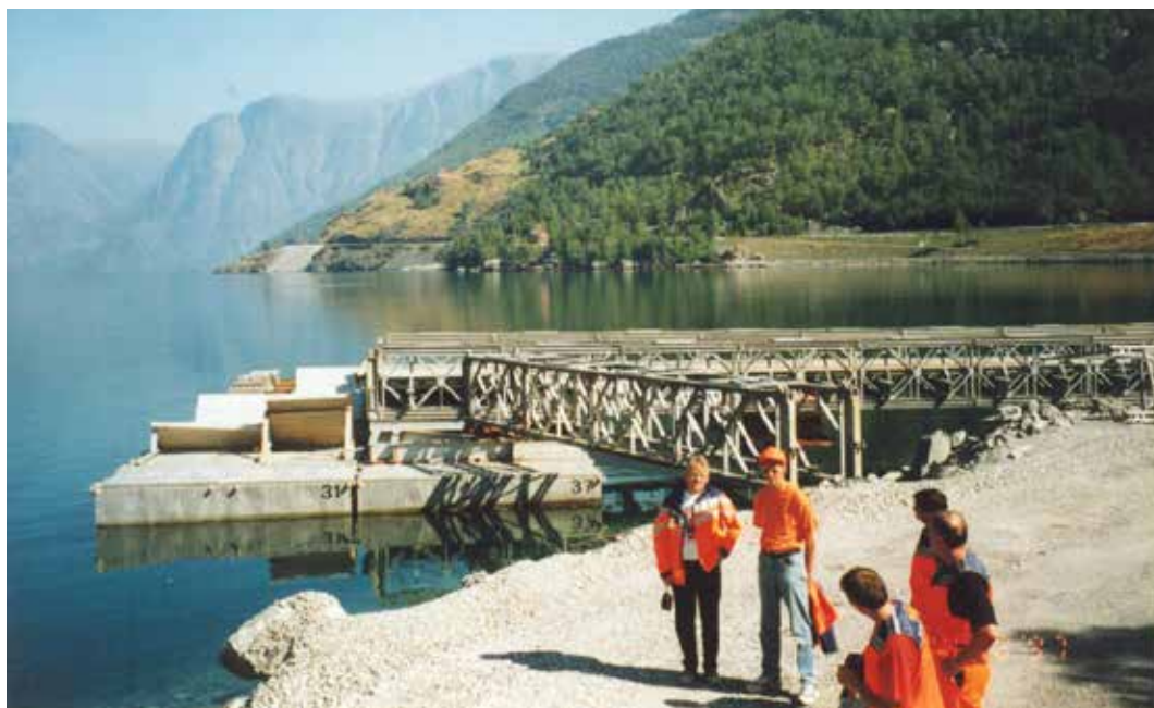
Figur 1-3- 9 Utfylling i sjø med bruk av Bailey bru og flåter (Foto: Frode Oset)
