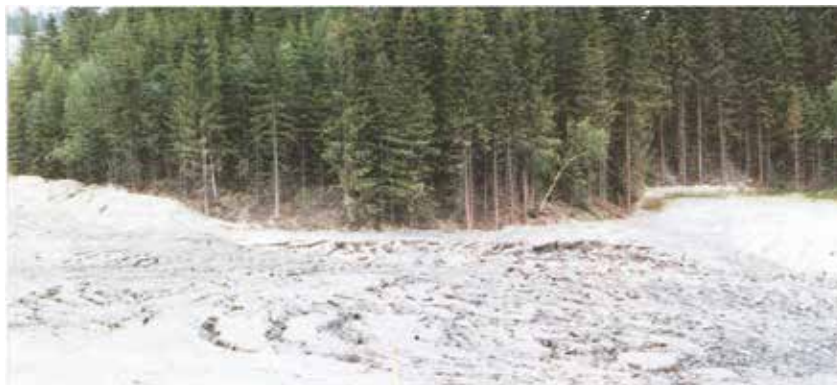
Figur 2-0-10 Ustabilitet i utfylte masser som følge av tining. (Foto: O.H.Hole, Statens vegvesen, Buskerud)
