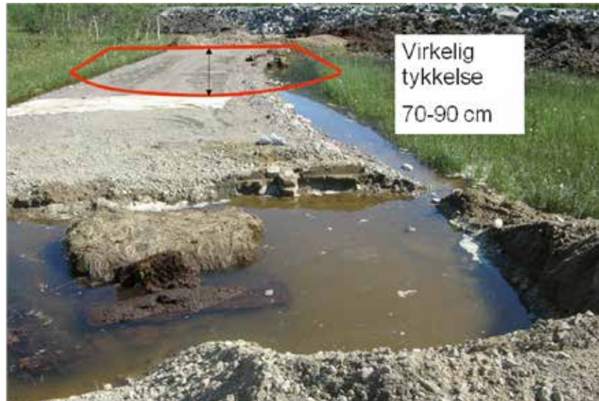
Figur 1-4- 25 Oppgraving og etterkontroll av anleggsveg for LoFast (Foto: Even Øiseth)
