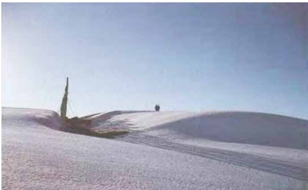
Figur 7-1. En effektiv snøskjerm skal samle store mengder med snø og i god avstand fra skjermen, og snøansamlingen under og på vindsiden av skjermen skal være minst mulig. (Foto: Ingvar Tøndel)
