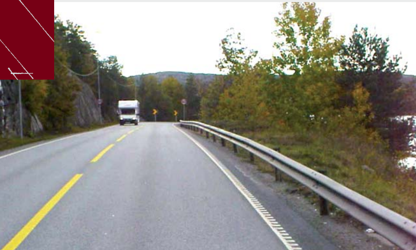
Vegens videre forløp før vegetasjonsrydding
