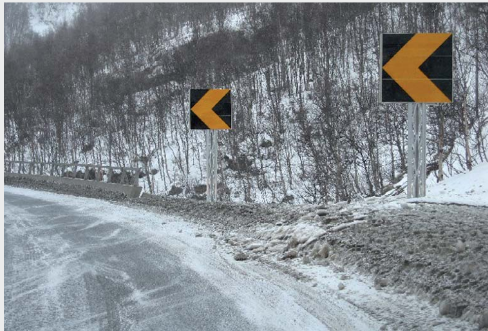
Her er retningsmarkeringer montert på nye gittermaster uten at rekkverksavslutningen er vurdert
