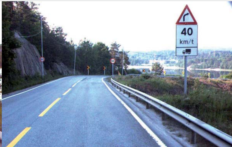
Vegens videre forløp etter vegetasjonsrydding
