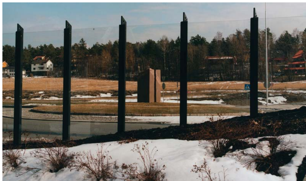
Glasskjerm mellom gang-/sykkelveg og kjørebane gir myke trafikanter utsikt til utsmykningen i rundkjøringen. LM
