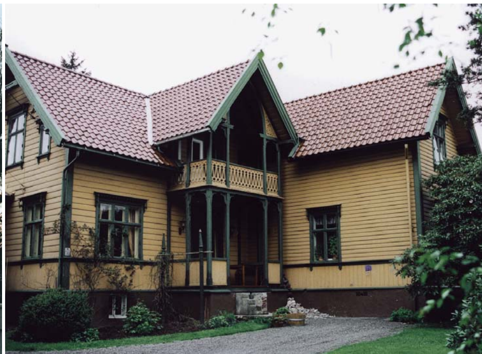
Med unntak av inngangspartiet, som er originalt er alle fasadene nye. Endringene virker tilforlatelige på avstand, men nært innpå fremstår huset som nytt. LM
