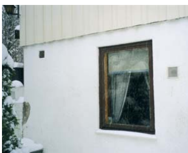
Ventilens utvendige side. Gammel ventilåpning kunne ikke benyttes da det ikke var nok plass til ventilboksen på innsiden, og den ble derfor tettet. LM
