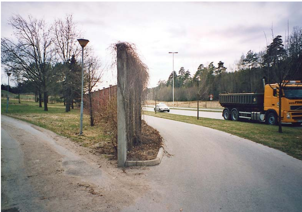
Støyskjermer kan i visse tilfeller gi noe reduksjon i støv-konsentrasjonen ved friarealer og boliger bak skjermen. LM
