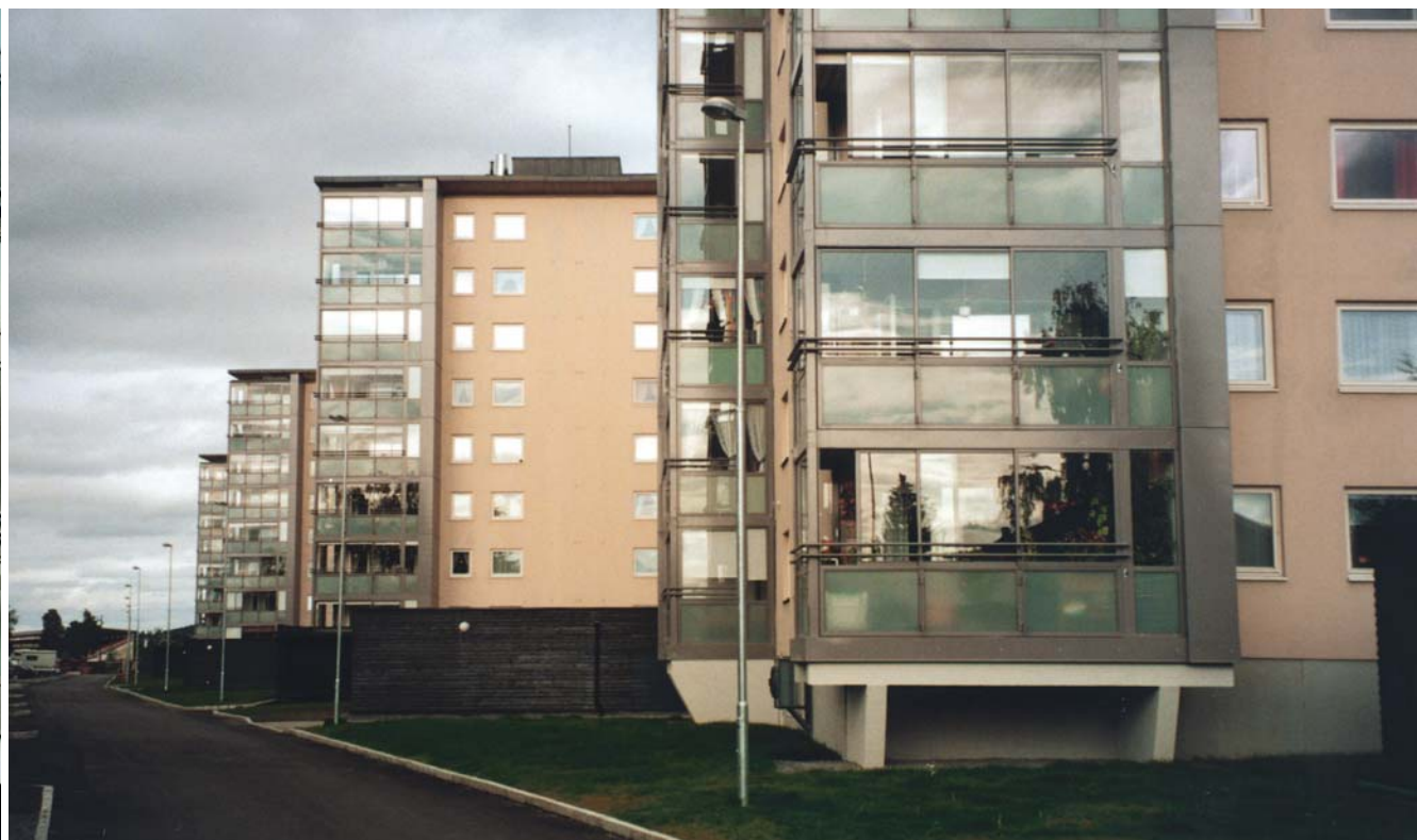
Bygging av Gardermobanen medførte total ombygging av flere boligblokker som konsekvens av støybelastningen i området. Installering av balansert ventilasjon krevde nye sjakter for kanalføring og balkongene måtte skjermes mot støy. Samlet førte kravene til et godt, nytt arkitektonisk grep der de nye fasadeelementene inngår i en helhetlig løsning. LM
