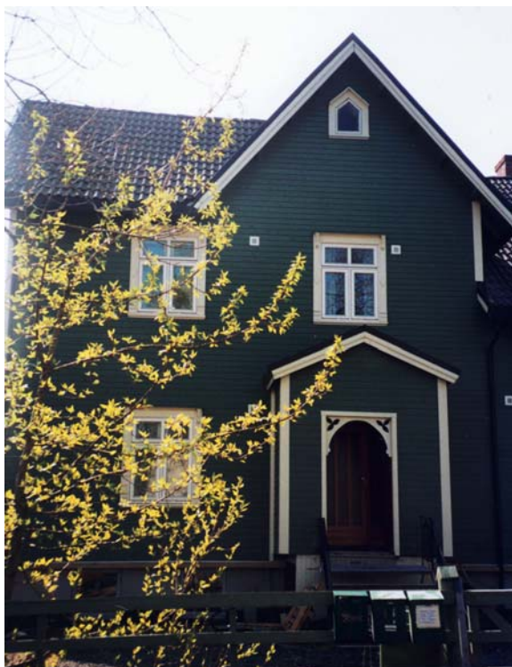
Bygningsdeler og proporsjoner er endret ved ombyggingen: innebygget inngangsparti, for små vinduer, plastbelagte beslag over vindskier og vannbord, uhøvlet panel, tilfeldig plasserte ventiler, nedløpsrør i plast mm. LM
