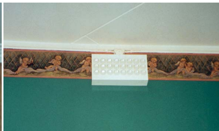
Her virker ventilen mer fremtredende ved at det ikke er tatt samme hensyn ved tilpassing til innvendig dekor. LM
