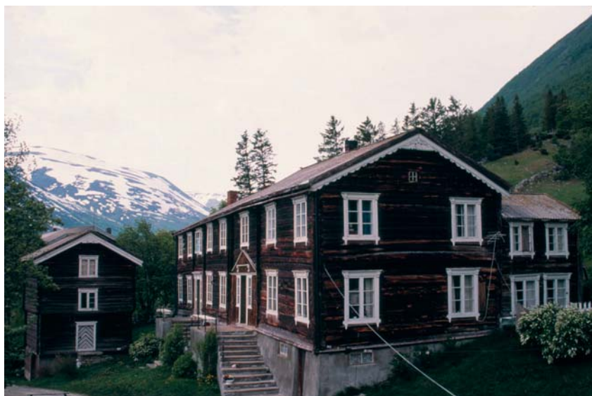
Byggeskikk: Gårdstun i Oppdal. JB
