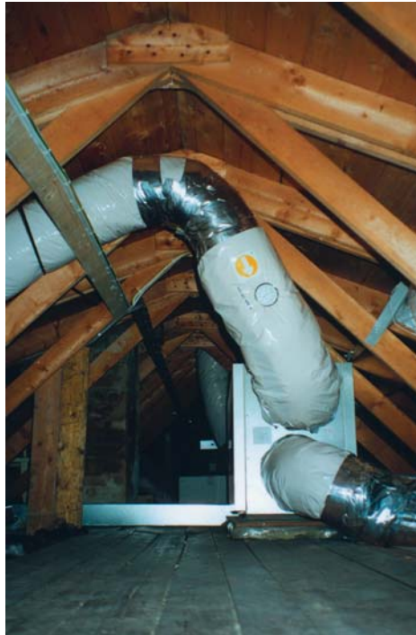
Ventilasjonsaggregat for enebolig plassert på loft. LM
