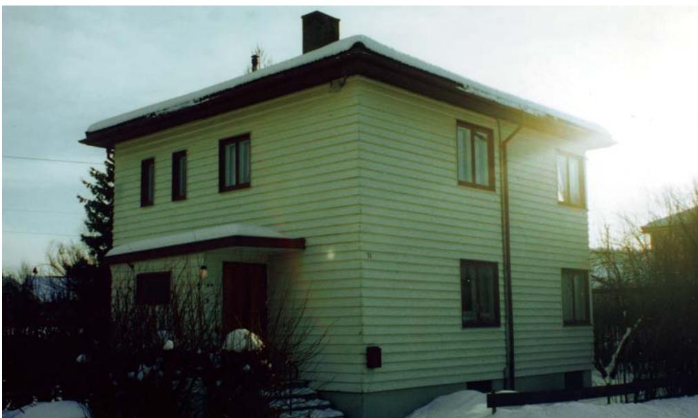
Byggmesterfunkis med liggende panel. På grunn av hjørneløsning med gjærede panelskjøter ble alle veggene kledd om ved etterisolering, selv om det ut i fra støyhensyn kun var nødvendig å utbedre tre av veggene. SO
