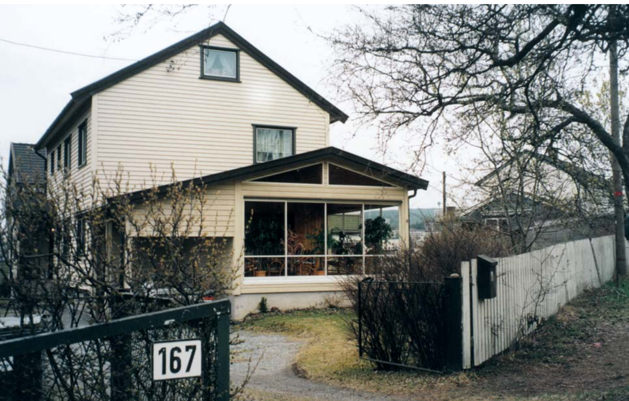
Områdeskjerm langs veg ga ikke tilstrekkelig støydemping av utvendig oppholdsareal på eiendommen, og huset fikk tilbygg med vinterhage. Den bygningsmessige standarden gjør at den etter hvert ble tatt i bruk som helårs stue. Tilbygget burde vært bedre tilpasset husets form. LM
