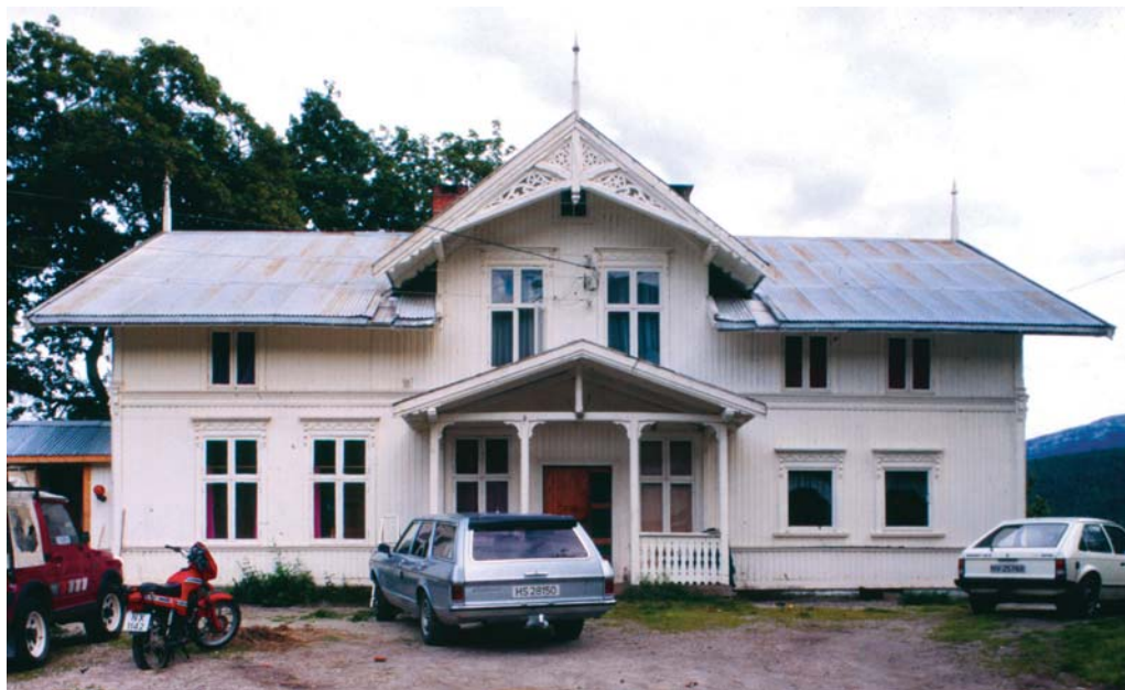
I fasaden til høyre for inngangspartiet er de opprinnelige vinduene erstattet av «husmor»-vinduer. JB
