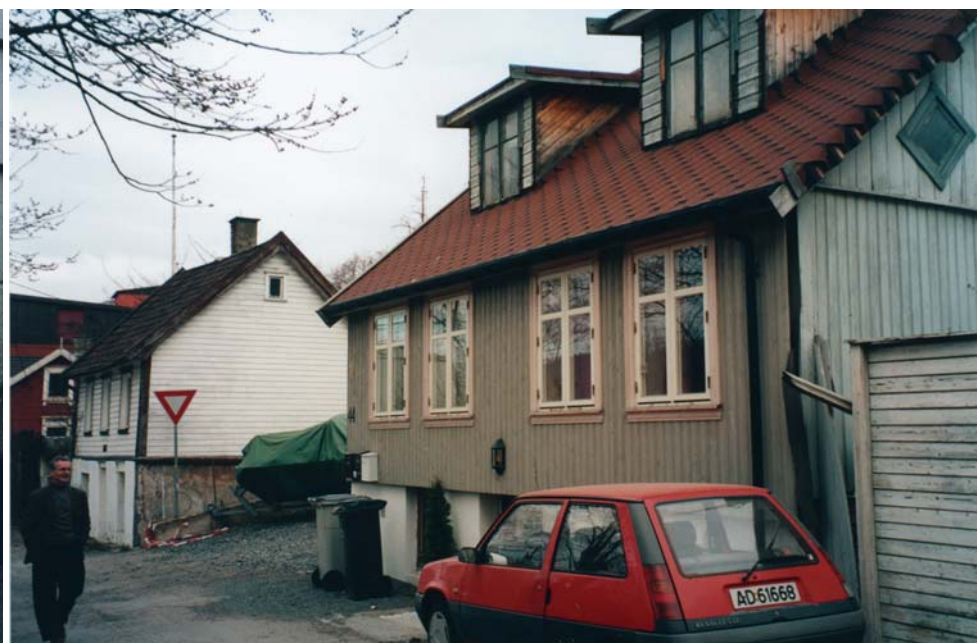
På dette huset har fasaden mot gaten allerede fått ny kledning, litt «finere» enn den opprinnelige som ses på gavlveggen.
