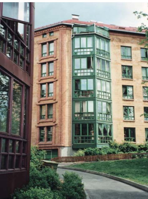
Innglassede balkonger inngår i stadig flere nye boligprosjekter i støytsatte områder. LM
