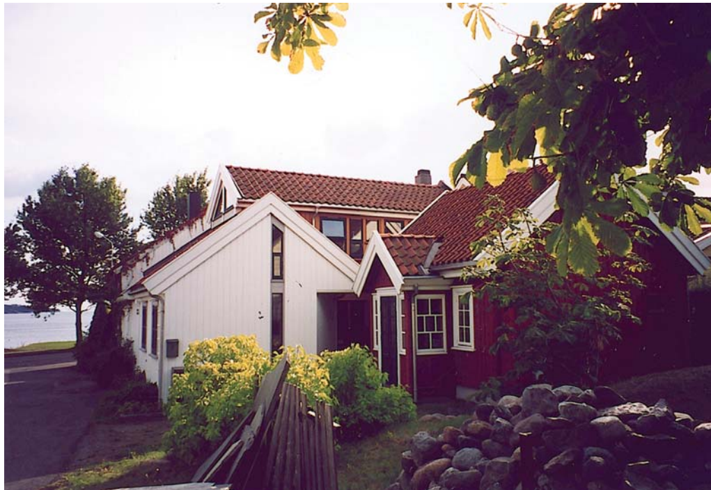
To små hus fra tidlig på 1800-tallet er pietetsfullt restaurert. Det mellomliggende tilbygget har en utforming som er fint tilpasset den eksisterende bebyggelsen. LM
