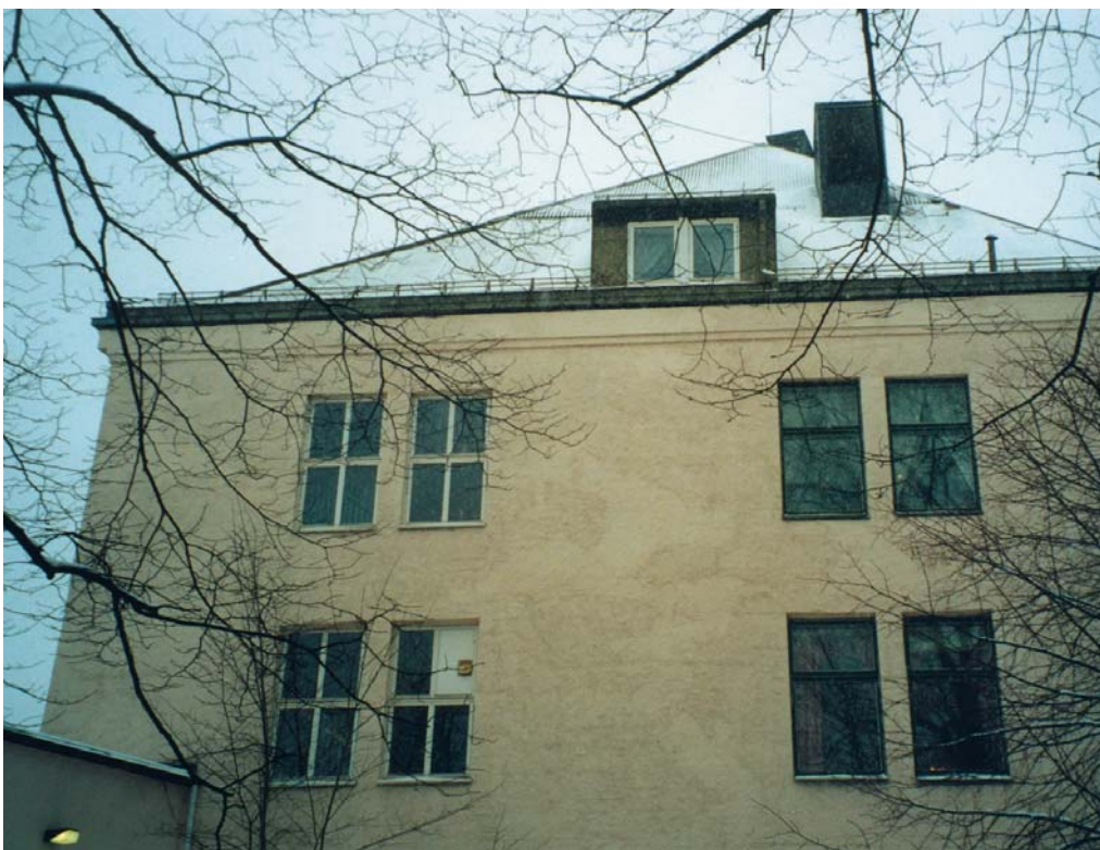
Avkaståpninger, som for eksempel jethetter, kan beslås for å virke mindre fremtredende på et gammelt tak. LM
