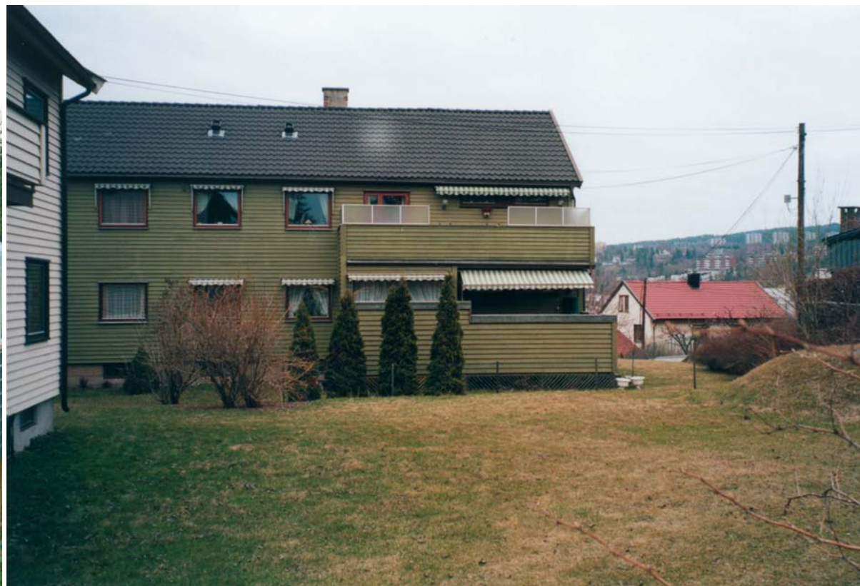
Balkongen i annen etasje har lokal skjerm i glass satt opp på eksisterende rekkverk/brystning. Terrassen under er delvis innebygget og et høyt tett gjerde rundt den åpne delen av plassen. Konstruksjonene gir en vesentlig endring i fasadeuttrykket. LM
