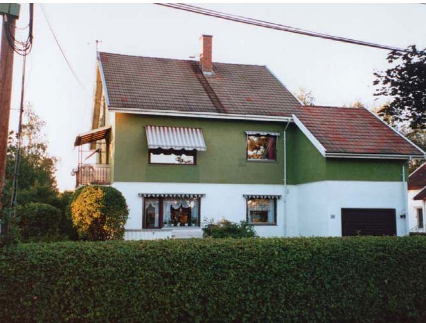
Balkongen på gavlveggen var eksponert mot støy. SO
