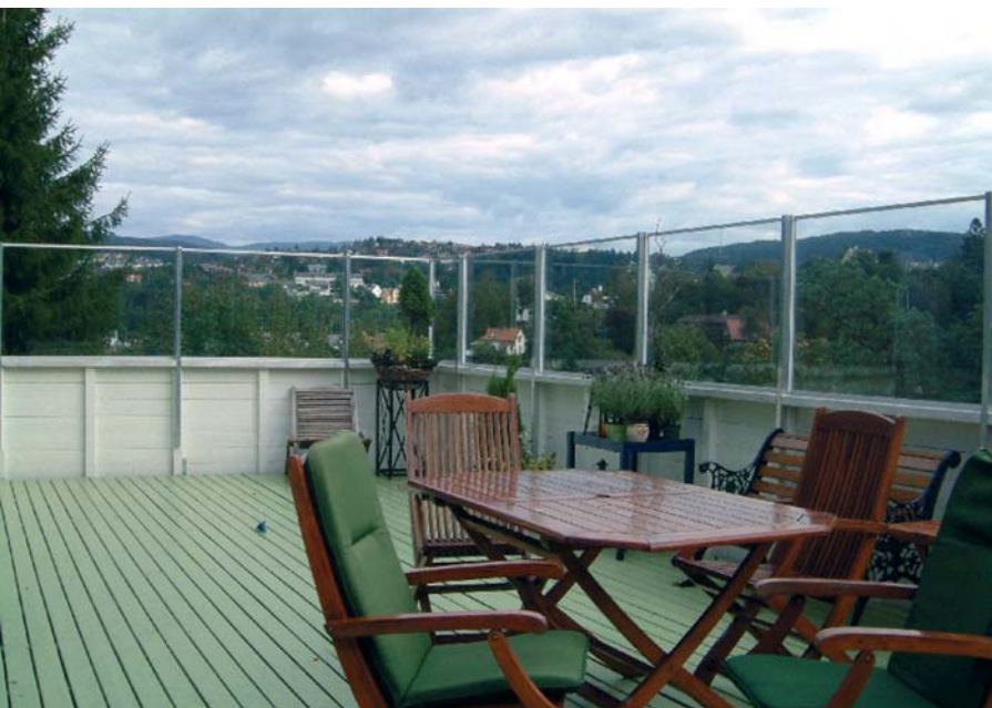
Bildet til venstre viser hvordan skjermen over til venstre arter seg fra innsiden. Bruk av glass er viktig for å beholde utsikten fra terrassen. Med en litt annen konstruksjon kunne topplisten med fordel vært utelatt, men løsningen er vesentlig nettere enn skjermen til høyre som er satt opp med rammeverk i tre. IM
