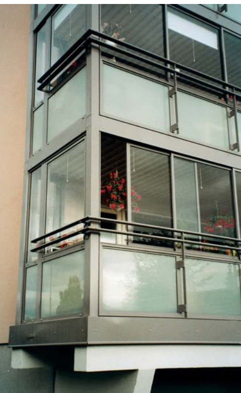
Balkongene har egen ventilasjon, men er utstyrt med skyvevinduer som kan åpnes når støyforholdene tillater det. LM
