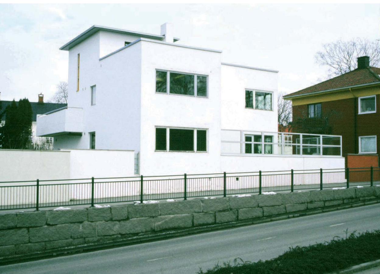
Terrassen på denne funkisvillaen hadde murt brytning som er forhøyet med en skjerm av glass i aluminiumsprofiler. AK
