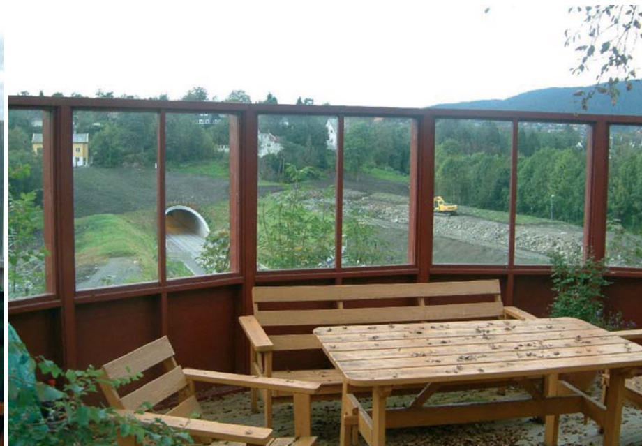
Bildet til venstre viser hvordan skjermen over til venstre arter seg fra innsiden. Bruk av glass er viktig for å beholde utsikten fra terrassen. Med en litt annen konstruksjon kunne topplisten med fordel vært utelatt, men løsningen er vesentlig nettere enn skjermen til høyre som er satt opp med rammeverk i tre. IM
