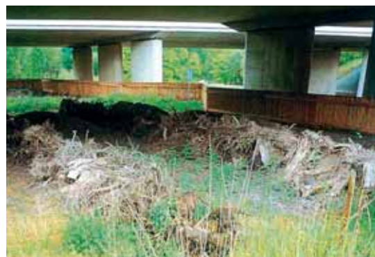
Figur 5-33: Stubber lagt ut som skjul for mindre dyr under en vegbru i Nederland. (Foto: H. Bekker)
