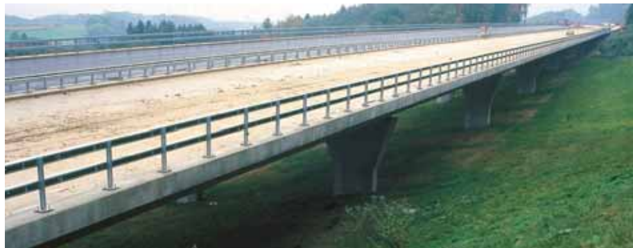
Figur 5-23: Eksempler på vegruer som sikrer passering for ulike dyrearter. Øvre bilde er fra Tyskland der vegen i stedet for å bli lagt på fylling ble lagt på bru for å bevare sletta.
