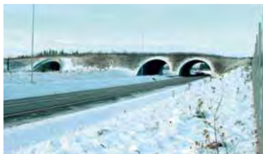
Figur 2-7: Samling av 4-felts motorveg (rv 35) og høyhastighetsjernbane (Gardermobanen) gir mulighet for en felles faunaovergang. (Foto: S. Guldseth)
