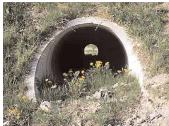
Figur 5-44: Kulvert i Tyskland for små dyr. Bunnen er fylt med jord for å gjøre den mer egnet for dyr. (Foto: V. Keller)
