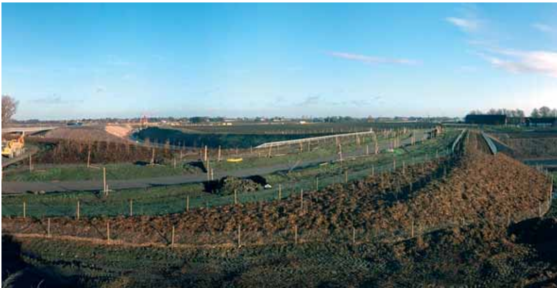
Figur 5-80: Overgang bygget over E6 utenfor Malmö, Syd-Sverige. Opprinnelig bygget som forbindelse mellom et lokalsamfunn og en kirke. Vegetasjonsstripe på begge sider brukes av kanin, piggsvin og grevling. (Foto: O. Eriksson)
