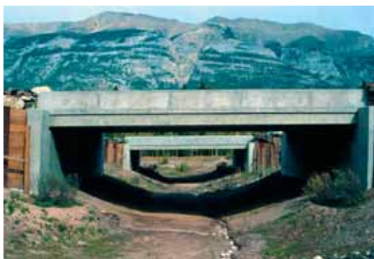
Figur 5-32: I Banff National Park i Canada ble veggen lagt på to parallelle bruer bl a for å dele opp undergangen i to korte deler i stedet for en lang, og for å sikre lys og vegetasjonsdekke i deler av passasjen. (Foto: B. Luell)
