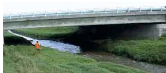
Figur 5-27: Om vegbruer bygges lange nok til at de naturlige elvebredder bevares, skaper det gode passeringmuligheter for mange arter under brua. Eksempel fra Tsjekkia. (Foto: J. Dufek)
