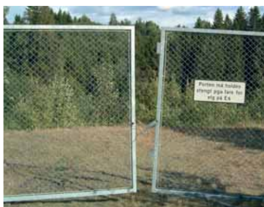
Figur 6-14: Porter i viltgjerdet må holdes forsvarlig lukket. Fra E6 i Eidsvoll kommune. (Foto: V. Meland)
