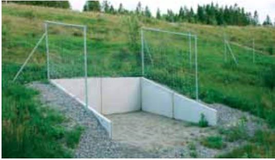
Figur 6-10: Viltuthopp fra E6 Rabbalshede i Sverige. En brukbar løsning der sideterrenget ligger lavere enn veien. (Foto: M. Lindquist)
