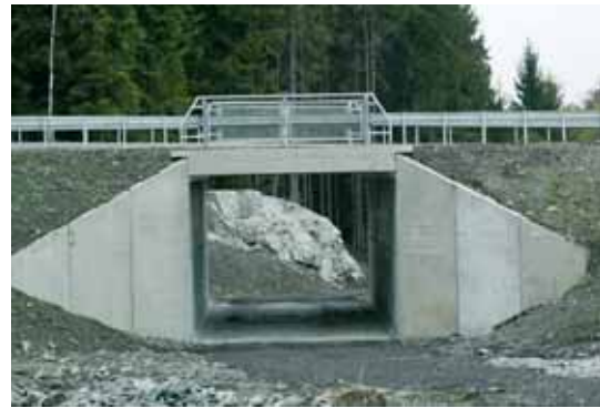
Figur 5-37: Landbrukskulvert under avkjøring fra E6, Ski, Akershus. Legges slike kulverter i rådyrenes trekkruiter og på steder hvor det er lite eller moderat menneskelig ferdsel, kan de utgjøre verdifulle kryssningspunkter. (Foto: B. Luell)
