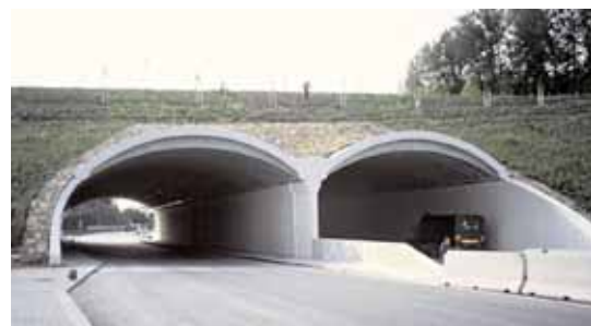
Figur 5-16: Overgang i Tsjekkia lagd av prefabrickerte betongelementer (Foto: H. Bekker)
