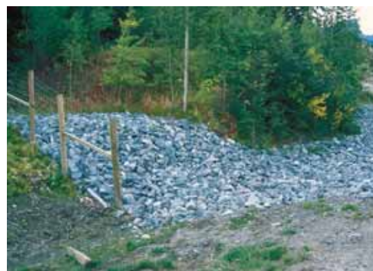
Figur 6-4: Avslutning av viltgjerd. Bilde fra Canada. (Foto: B. Luell)
