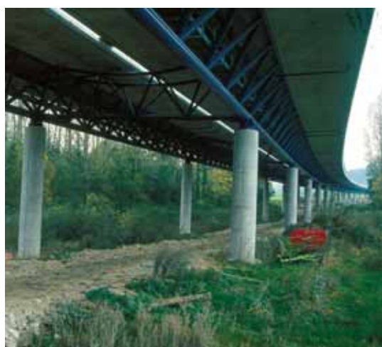
Figur 5-24: Vegbru over våtmark; A1 Sveits. Brua ble lagt på pæler, og anleggsvegen under ble fjernet da anlegget sto ferdig. (Foto: B. Iuell)
