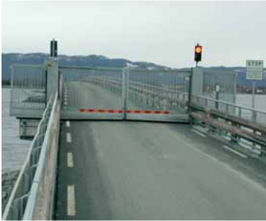
Figur 6-31: Automatisk lukkende port foran bruen ut til Tautra. (Foto: B. Iuell)
