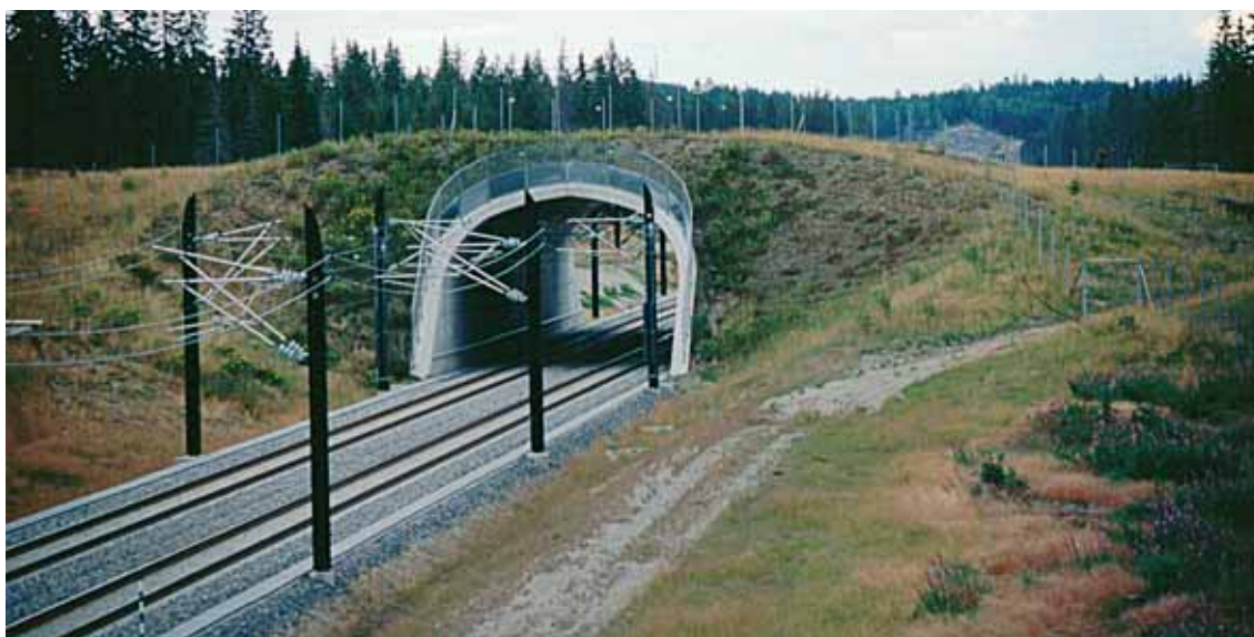
Figur 7-14: Faunapassasje over Gardermobanen nord for flyplassen. Overgangen som er 40 m bred er lagt i et viktig trekkområde for elg. (Foto: L. Kastdalen)
