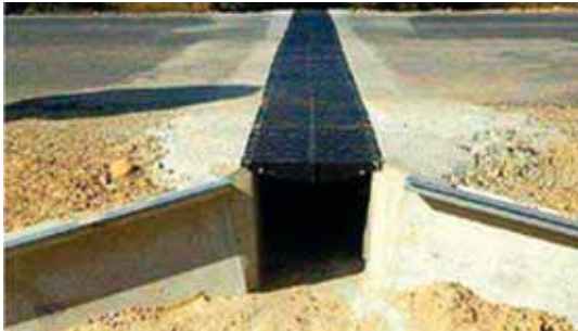
Figur 5-75: Amfibiekulvert med en åpen rist i Spania. (Foto: C. Rosell)
