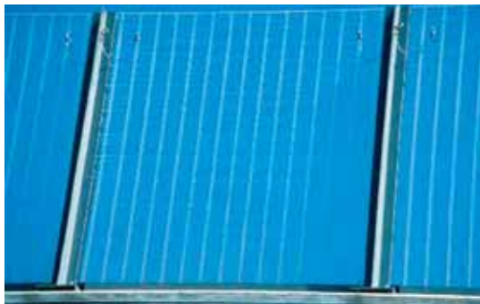
Figur 6-25: Del av en gjennomsiktig skjerm i Sveits med hvite lodderette markeringer. Fugl vil oppfatte dette som et stengsel, mens trafikkanter i fart knapt vil registrere stripene. Lyse farger er å foretrekke fremfor mørke. (Foto: H. Schmid)
