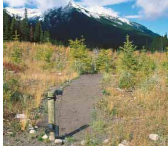
Figur 7-8: Registrering av passeringer på en faunaovergang i Banff, Canada. Her brukes sandgrop, fotocellestyrt telling og infrarød fotografering i kombinasjon. (Foto: B.Luell)
