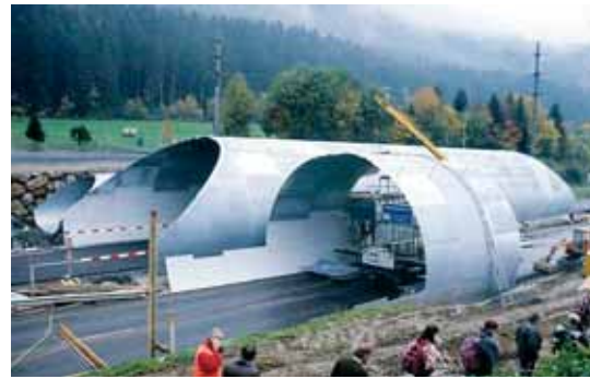
Figur 5-4: Elementer av korrugert stål ble brukt i denne 40 meter brede overgangen i Sveits. Overgangen ble anlagt i forbindelse med utvidelse av veggen fra to til fire felt. Løsningen gjør det mulig å ha to felt åpne for trafikk i anleggsperioden. (Foto: O. Holzgang)
