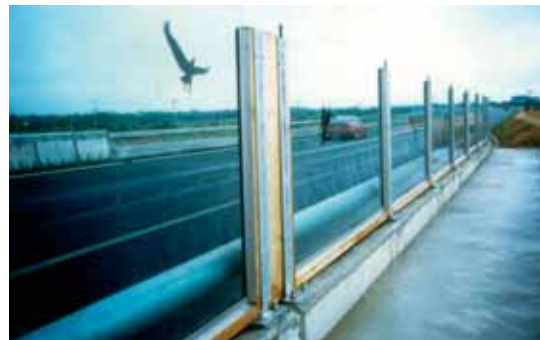
Figur 6-26: Silhuetter av rovfugl har vist seg å være lite effektivt for å forhindre fugler å fly på transparente støyskjermer. (Foto: C. Rosell)
