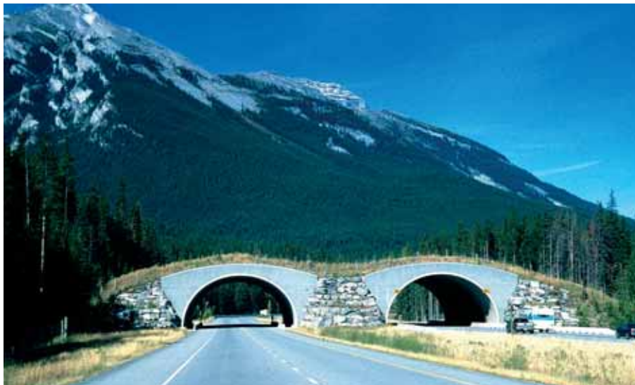
Figur 5-7: Denne overgangen i Banff nasjonalpark i Canada ble bygd med prefabriserte elementer ved utvidelse fra 2-felts til 4-felts motorveg. (Foto: B. Iuell)
