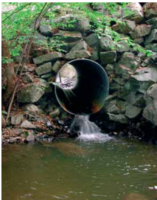
Figur 5-59: Liten vannføring og fall fra røret til bekken vanskeliggjør oppgang av fisk. (Foto: B. Luell)
