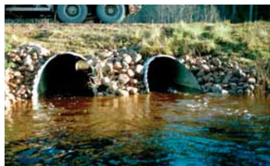
Figur 5-60: Øverst: Disse to kulvertene under rv 45 i Mora i Sverige utgjorde et vandringshinder for ørret som skulle vandre oppstrøms. Vegen har mye trafikk og det var derfor vanskelig å få gjort noe med plasseringen av kulvertene. Nederst: Etter heving av vannspeilet nedstrøms ble situasjon bedret. (Begge foto: A. Bruks)
