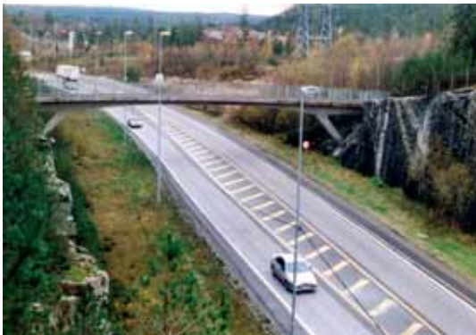
Figur 5-19: Bru for friluftsmål over E6 ved grensa mellom Ski og Oslo. Brua er lang og smal, og er uegnet som faunapassasje. (Foto: V. Meland)
