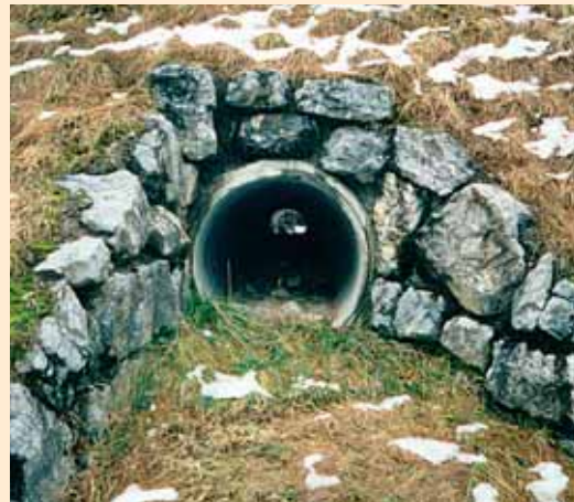
Figur 5-49: En liten faunakulvert med en grevling i Nederland. Denne typen kulverter kan brukes av små rovdyr, mus og amfibier. Diameter: 0,3-0,6 m. (Foto: Vereniging 'Das en Boom')
