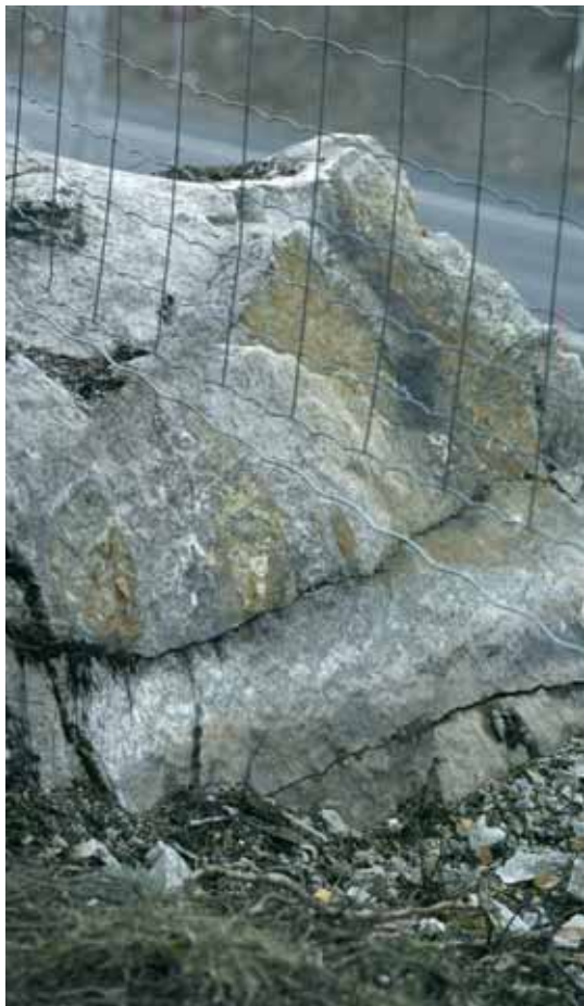
Figur 6-7: Der viltgjerdet er satt opp på fjellgrunn, kan det lett bli åpninger under nettingen. Disse må tettes slik at dyr ikke kan krype under. (Foto: B. Luell)
