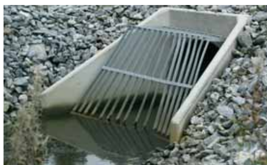
Figur 5-61: Inntaksristen er montert med ca 20 cm klaring til kummen. Dette gjør det mulig for fisk å passere selv om kvist fester seg i risten. (Foto: B. Luell)
