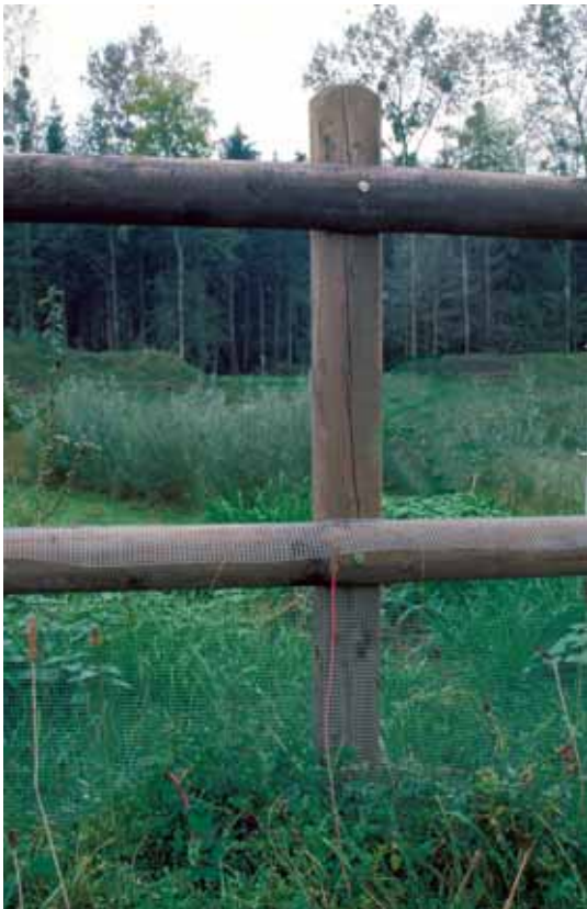
Figur 6-17: Netting oppsatt for å hindre at amfibier får adgang til sedimentasjonsdam. Ved A1, Sveits. (Foto: B. Luell)
