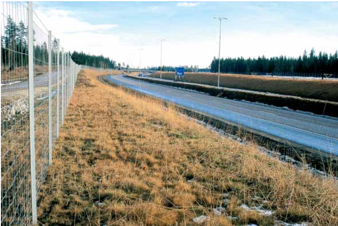
Viltgjerd er det mest effektive tiltaket mot viltpåkjørslar, men må brukes med måte. Rv 35, Gardermoen. (Foto: B. Iuell)
