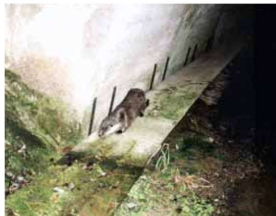
Figur 5-54: En planke plassert i en kulvert gir oter gode passeringmuligheter. Bilde fra Tsjekkia. (Foto: V. Hlavác)
