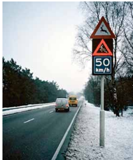
Figur 6-23: Viltvarslingssystem fra Sveits. Viltskiltet er koblet til en varmesensor som gjør at skiltet lyser når det er hjort i området. (Foto: H. Bekker)
