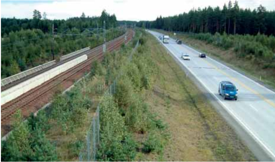
Figur 6-3: Eksempel på plassering av viltgjerd på E6 i Ullensaker kommune. Vegen er gjerdet inn på begge sider, men gjerdet er satt mellom vegen og jernbanen. Det fører til større sjanse for vilt-påkjørsler på jernbanen enn før gjerdene ble satt opp. (Foto: V. Meland)
