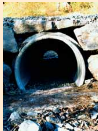
Figur 5-73: Paddetunnel under fv 41 i Volda. Det er lagt naturlig elvegrus på bunnen. (Foto: S. Lunde)
