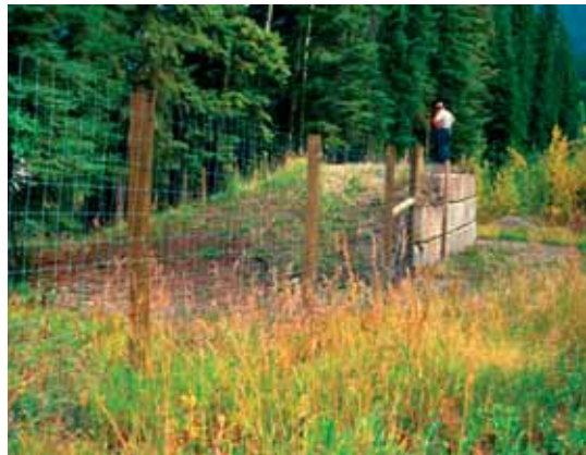
Figur 6-12: Eksempler på enkle fluktrammer fra viltgjerdet i Spania (de to øverste bildene) og Canada. (Foto: H. Bekker og B. Luell)
