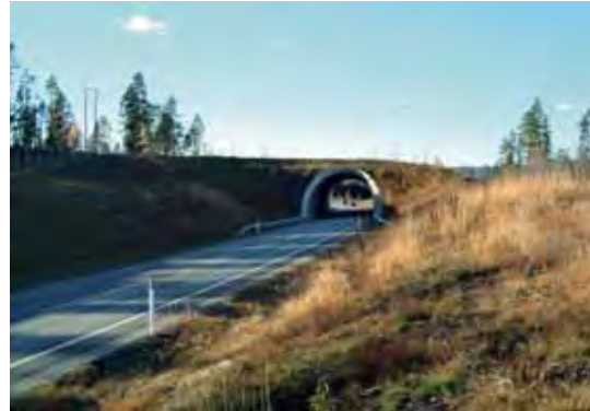
Figur 3-3: Eksempel på avbøtende tiltak. Planlagt (venstre) og ferdig (høyre) faunapassasje på ny rv 35 mellom Roa og Gardermoen. Fotoet av overgangen ble tatt like etter ferdigstilling, og lite vegetasjon var foreløpig etablert. (Illustrasjon og foto: W. Hollum)
