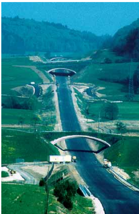
Figur 5-3: 3-felts motorveg B31n i Syd-Tyskland deler opp et område langs en større innsjø. Det er etablert flere faunapassasjer for å unngå at habitater blir isolert. Her er det brukt en kombinasjon av brede faunaoverganger og smalere overganger kombinert med landbruksoverganger. (Foto: V. Keller)
