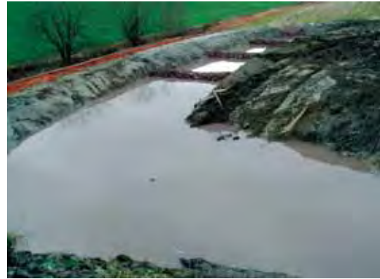
Figur 2-10: Sedimenteringsbasseng etablert under anleggsperioden ved ny E18 Kopstad – Gulli, Vestfold. Det skal ta opp utslipp fra driving av tunnel, finstoff og luften vannet fra tunneldrivingen mht ammoniakk. Avrenning fra 120 da avdekket område. (Foto: C.E. Dahl)
