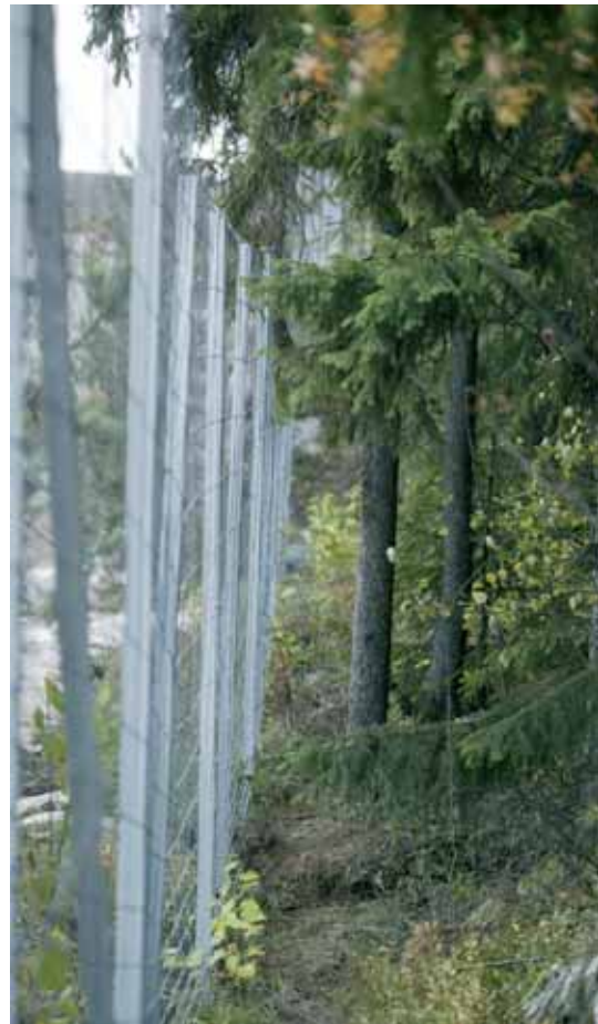
Figur 6-9: Nettingen kan settes opp på utsiden av stolpene selv der det er trangt. (Foto: B. Luell)
