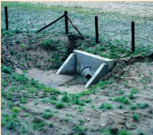
Figur 5-48: Eksempel på uheldig plassering av en grevlingtunnel i Nederland. Den ligger så lavt i terrenget at den har blitt fylt med sand og vann. (Foto: H. Bekker)
