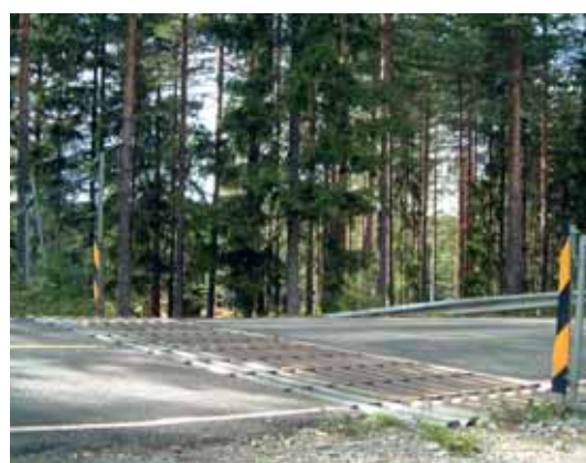
Figur 6-16: Ferister er oftest brukt for å holde husdyr innenfor et beite eller å hindre dem i å komme ut på en hovedveg. De kan også brukes på sideveger for å forhindre at ville dyr kommer ut på en hovedveg med viltgjerder. (Foto: V. Meland)
