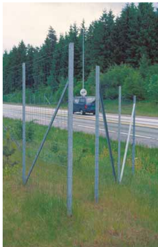
Figur 6-19: Det indre ledegjerdet i viltslusene skal ikke festes til viltgjerdet. (Foto: B. Luell)
