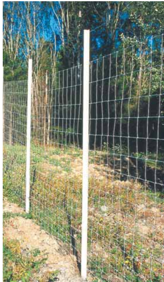
Figur 6-6: Viltgjerde langs rv 23 i Akershus. Legg merke til ulik maskevidde på øvre og nedre del av gjerdet. (Foto: B. Luell)
