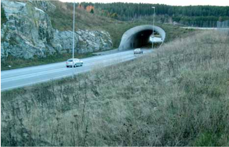
Figur 5-2: Når veien ligger lavt i forhold til sideterrenget, kan det være gunstig å bygge en overgang. Her fra E6 i Østfold. (Foto: B. Luell)
