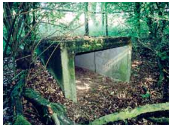
Figur 5-45: Denne rektangulære kulverten i Nederland er 2 m bred, 0,8 m høy og 40 m lang, og brukes ofte av grevling. (Foto: H. Cormont).
