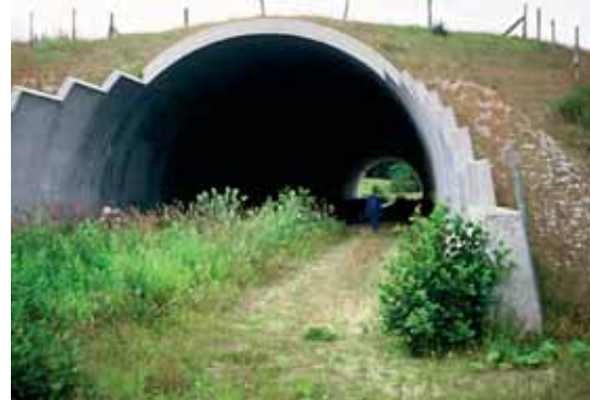
Figur 5-39: Denne kulverten i Danmark har en diameter på 13 meter, høyde på 8 meter og er 87 meter lang. Den brukes regelmessig av bl a rev, grevling og mår, foruten mennesker. For hjortedyr er åpenhetsindeksen for liten. (Foto: B. Wandall)
