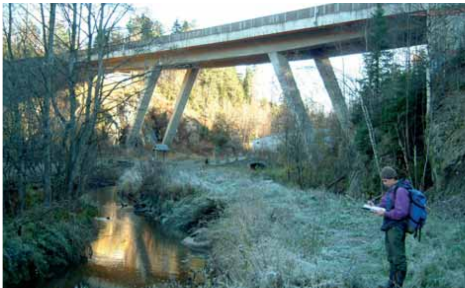
Figur 5-21: E6 lagt på høy bru over Dalselva i Ski kommune sikrer hjortevilttrekk under brua. (Foto: Ø. Flåtten/Multiconsult AS)
