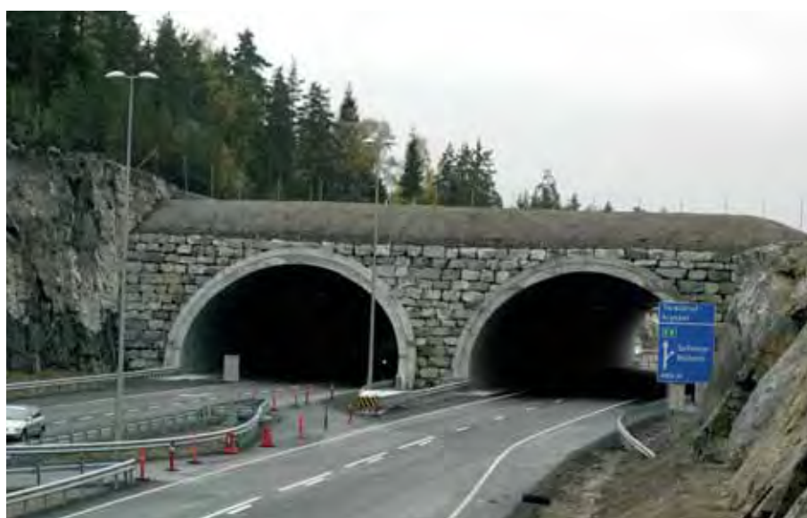
Figur 4-1: Øverst: Faunapassasje ved Taraldrudkrysset på E6 i Ski kommune ble bygget over eksisterende veg ved utvidelse fra 2 til 4 felt. Nederst: Ferdig bygget 2004. (Foto: B. Luell)
