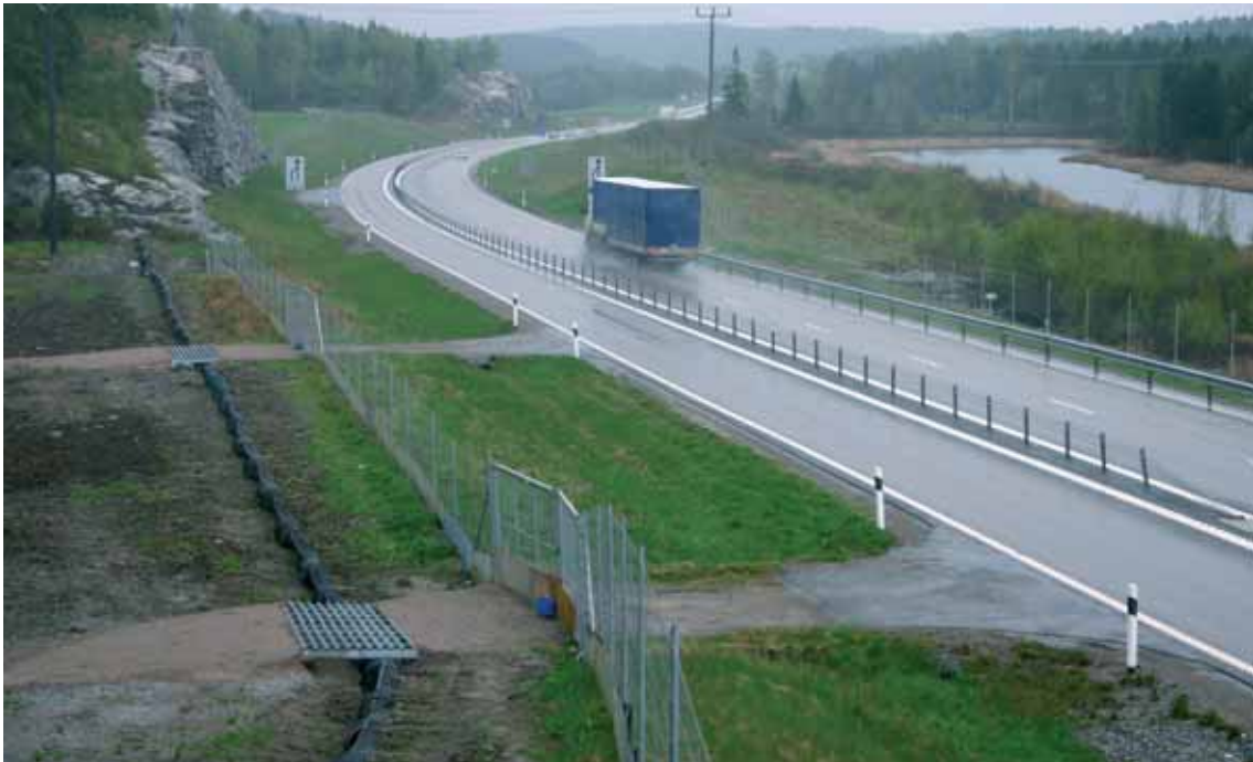
Figur 5-70: Langs rv 161 i Sverige ble det laget ledegjerder for amfibier laget av avkuttete plastrør. Prinsippet var bra, men dessverre viste det seg at platen ikke var sterk nok til å stå imot vekten av massene i bakkant. (Foto: M. Lindqvist)
