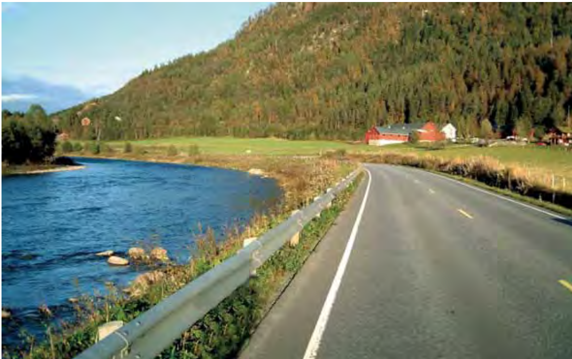
Figur 2-15: Her er det sparsomt med kantvegetasjon mellom vegen og elva, og vandringsmulighetene langs elva er dårlig for landlevende dyr. Elva Surna og rv 65 i Surnadal kommune (Foto: V. Meland).
