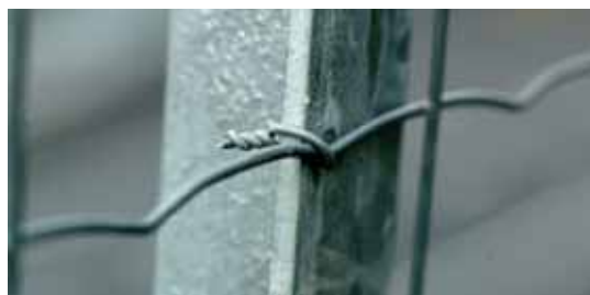
Figur 6-8: Nettingen festes til stolpene med ståltråd. Festes netting på den siden som vender mot vegen, er det kun ståltråden som holder igjen når dyr legger seg mot nettingen. (Foto: B. Luell)
