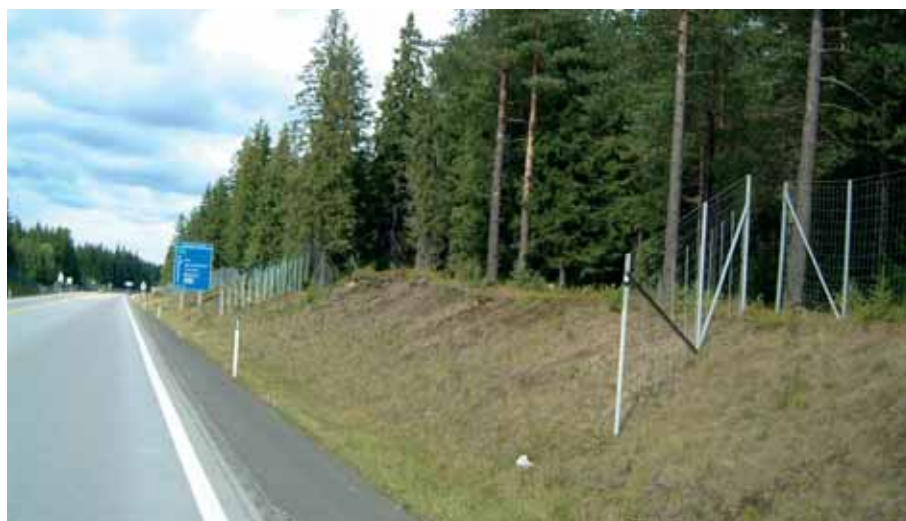
Figur 7-15: Viltsluse på E6 i Ullensaker. (Foto: V. Meland)
