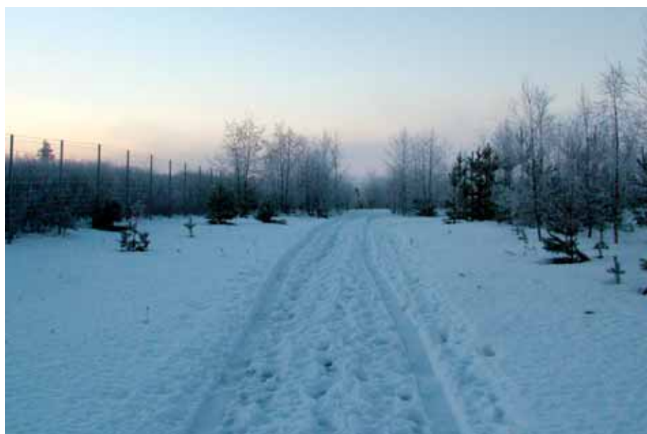
Figur 5-10: I perioden rett etter etablering vil det være lite naturlig vegetasjon på en faunaovergang. Ved riktig beplantning og rikelig med markdekke vil det etter hvert vokse opp vegetasjon som kan tjene som både skjerming og før. Her fra faunaovergangen over rv 35 ved Gardermoen rett etter åpning (Foto: B. Luell) og 5 år etter (Foto: S. Guldseth)
