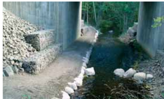
Figur 5-31: Smal kulvert med vann og tilrettelegging for passering av landlevende dyr. Kulverten er bygget med naturlig bunn. Moabäcken, Sverige. (Foto: M. Lindqvist)
