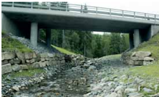
Figur 5-30: På rv 35 i Lunner er det bygget flere underganger for villt. Her er det lagt til rette for både vann- og landlevende dyr. (Foto: B. Luell)
