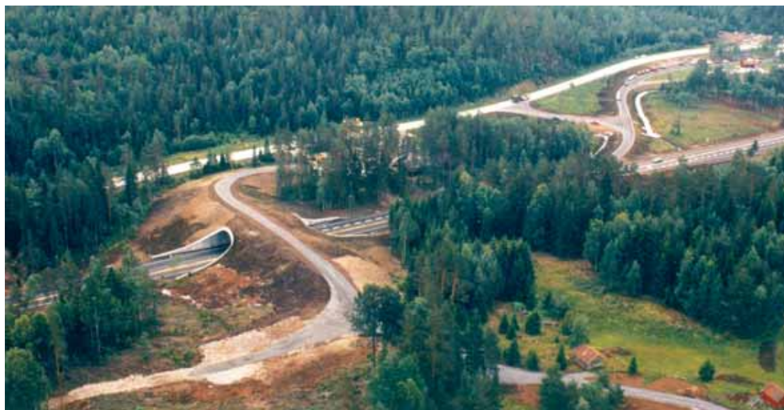
Figur 5-78: Faunapassasjen over E18 på Østerholtheia. På faunapassasjen er det anlagt en grusvei som fører til et mindre småbruk. (Foto: Statens vegvesen)
