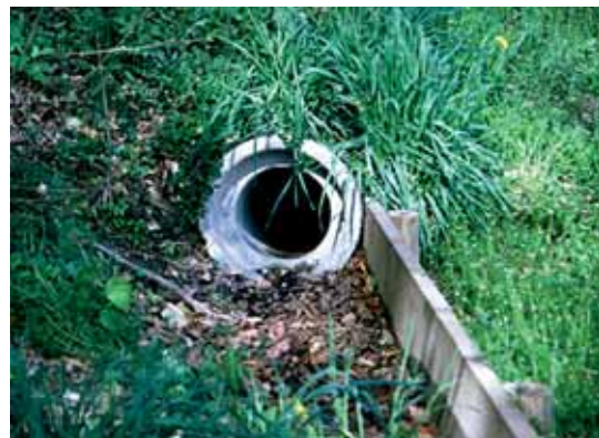
Figur 5-47: Kulvert for små dyr i Danmark. Legg merke til planken som skal lede dyr mot kulverten. (Foto: B. Winterberg)
