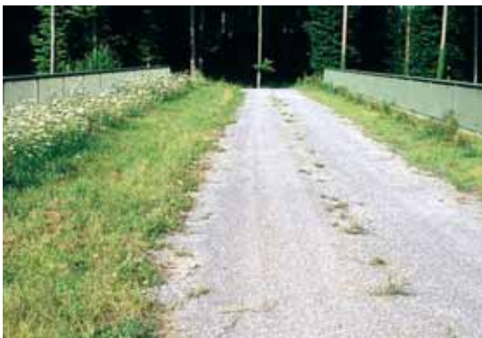
Figur 5-20: Vegetasjonsstripe langs en skogsbilveg kan gjøre brua egnet for passering av dyr. Bru over motorveg nær Oberderdingen i Tyskland. (Foto: B. Georgii)
