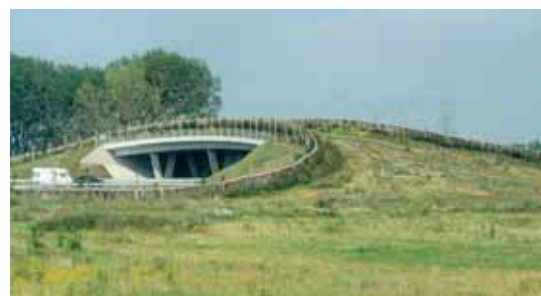
Figur 5-17: Faunaovergang i Ungarn. Fordi vegen ikke ligger spesielt tungt i terrenget, har det vært nødvendig med betydelige markarbeider for å slake ut skråningene opp mot overgangen. Gjerdene leder dyrene mot overgangen. (Foto: P. Farkas)
