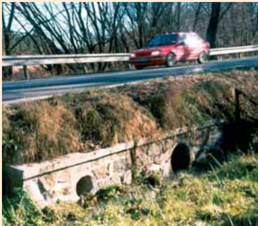
Figur 5-50: Oter unngår helst vannfylte kulverter når de skal krysse en veg. Små kulverter plassert over vannivået kan være en mulighet til å få oteren til å bruke dem, som på dette bildet fra Tsjekkia der oterkulverten ligger til venstre. (Foto: V. Hlavác)
