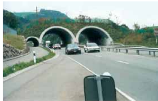
Figur 5-5: Dette bildet viser den samme overgangen som på Figur 5-4 ferdig bygget. (Foto: V. Hlavác)
