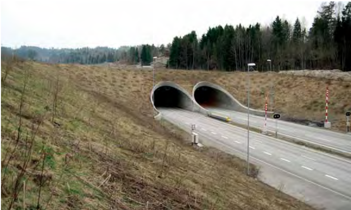
Figur 3-5: Miljøtunnel (Island) E18 Vestfold. 400 meter lang løsmassetunnel. Vegen ligger tungt i terrenget både for å redusere støyplagen og for å gi dyreliver en mulighet til å passere over vegen. (Foto: O. Lervik)
