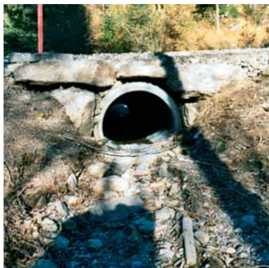
Figur 5-69: Paddetunneler under fv 41 i Volda. Tunnelene er lagt der det er registrert vandringer. (Foto: S. Lunde)
