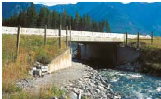
Figur 5-28: Kryssing av elv kombinert med passasje for landlevende dyr, Banff, Canada. (Foto: B. Luell)
