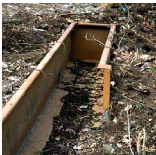
Figur 5-72: Ende av ledeanordning, Tyskland. Den U-formete avslutningen tvinger amfibier som går feil veg til å snu. (Foto: S. Zumbach).
