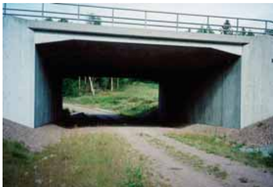
Figur 5-38: Ved å øke bredden på en landbrukskulvert vil den bli et egnet passeringsspunkt for dyr. (Foto: O. Eriksson)
