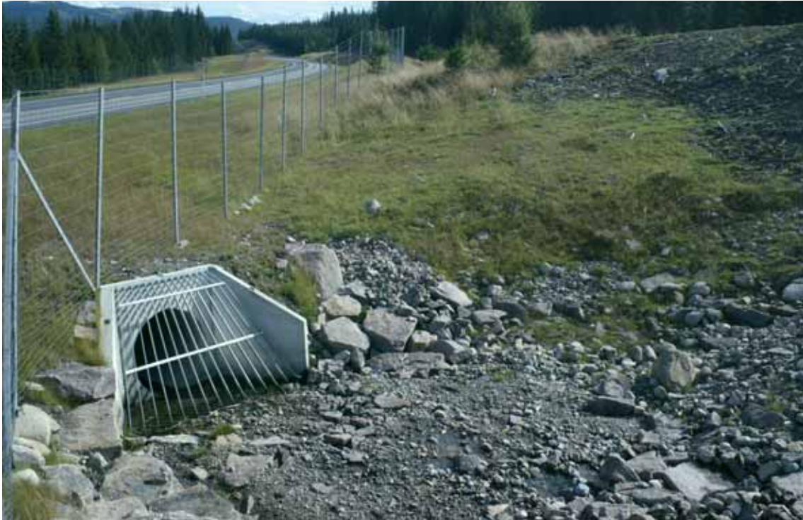
Figur 5-55: Inntakskum på rv 35 med inntrukket gjerde. Inntaksrist reduserer muligheten for dyr til å passere. (Foto: B. Luell)
