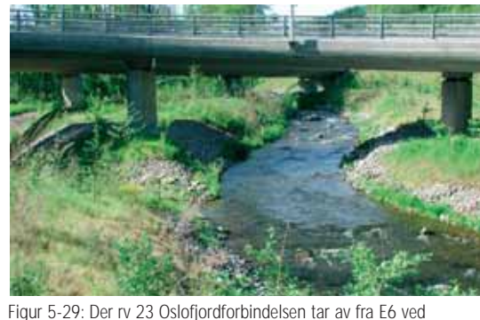
Figur 5-29: Der rv 23 Oslofjordforbindelsen tar av fra E6 ved Vassum over Årungsella er det tatt hensyn til å bevare både elva og kantvegetasjonen. (Foto: B. Luell)
