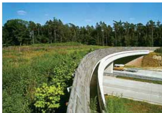
Figur 5-11: Denne viltovergangen i Nederland har en avskjerming av tre. Avskjermingen må stå så nær ytterkanten som mulig slik at man oppnår maksimal bredde for dyrene. (Foto: H. Cormont)
