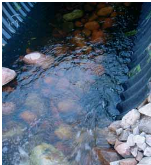
Figur 5-63: Kulverten bør graves dypt ned, og eventuelt fylles med naturlig bunnssubstrat. Større steiner bidrar til å stabilisere bunnen, og skaper skjul for mindre fisk. (Foto: A. Bruks)
