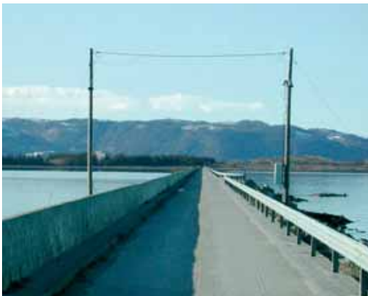
Figur 6-29: Lydsperre på veggen ut til Tautra før bygging av bru. (Foto: B. Iuell)
