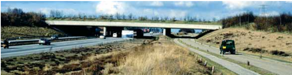
Figur 5-13: Overgang fra Terlet i Nederland. Det er en rett betongstruktur på søyler. Vegen er senket slik at overgangen krysser i nivå med det omkringliggende landskap. (Foto: V. Keller)
