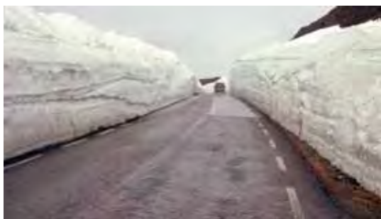
Figur 2-6: Høye brøytekanter langs vegen kan forsterke barrieren. Dyr som kommer ned på vegbanen kommer ikke opp igjen, og risikerer å bli påkjørt. Her fra rv 13, Vikafjellet. (Foto: B. Luell)
