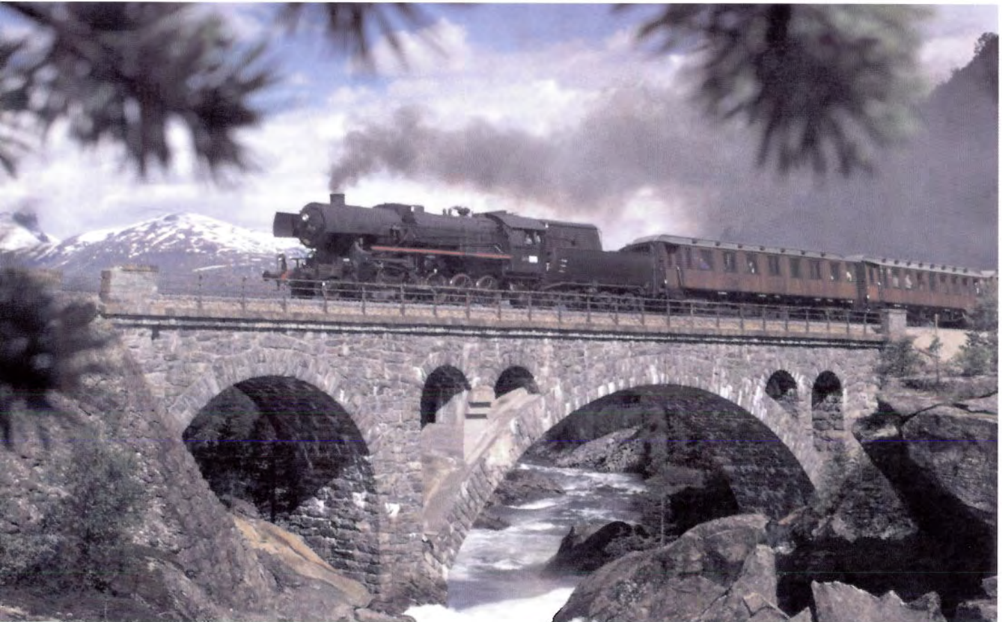
Stuguflåten bru på Raumabanen (1922). Reparasjoner etter skader fra sprengningsforsøk i 1944 synlig. Foto: SCANPIX/Stein J Bjørge.
