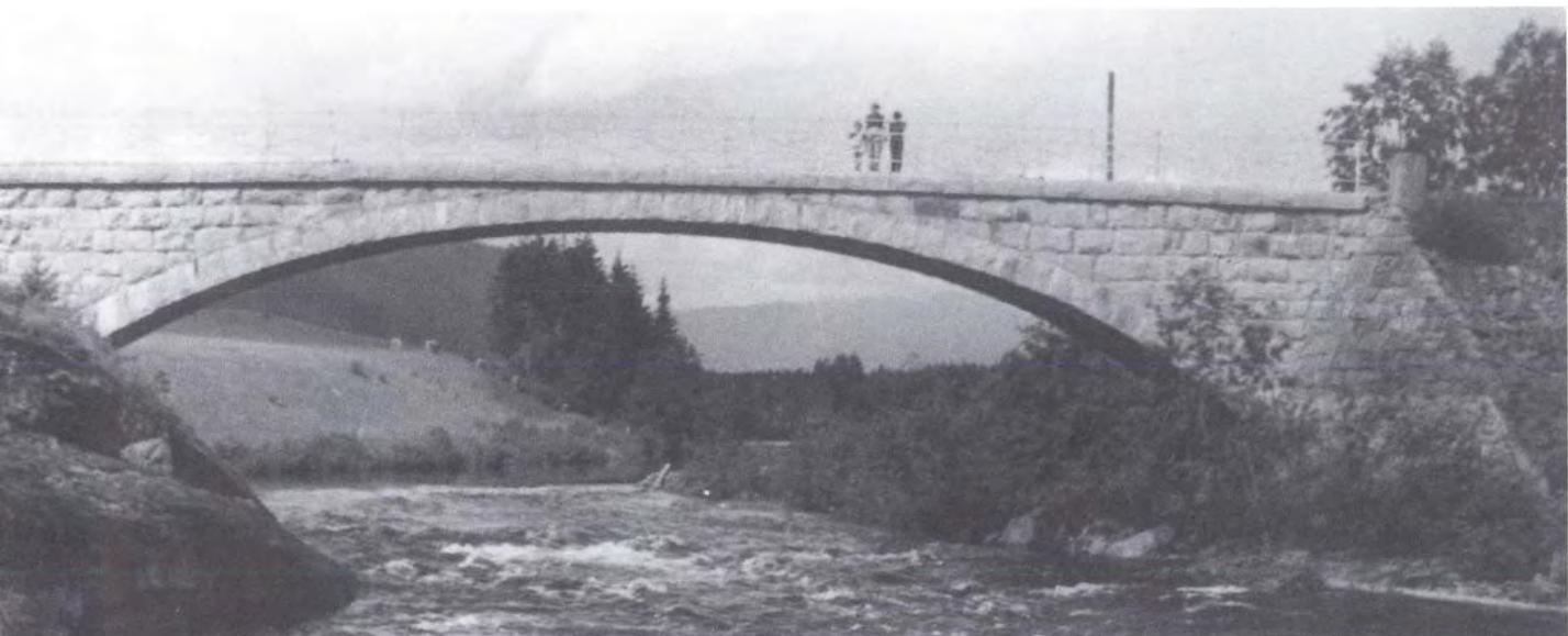
Ertesprang bru, Sigdal i Buskerud. Bygget 1915, revet 1991. Hogget stein i sementmørtel. Foto: Statens vegvesen.
