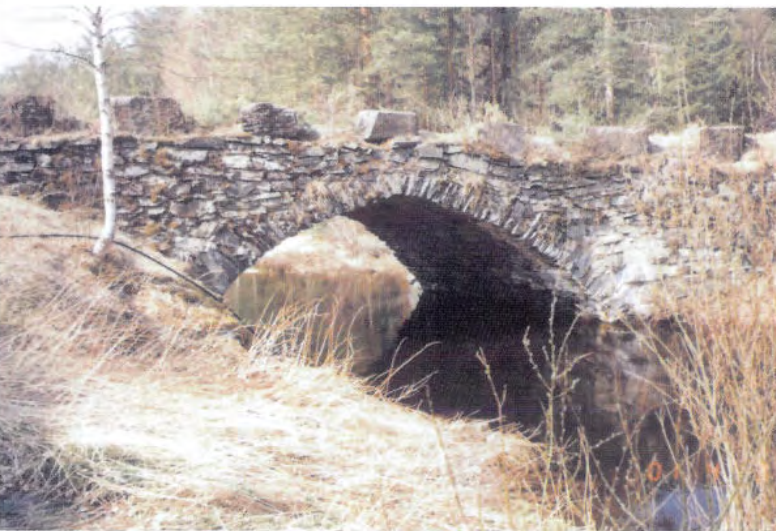
Smedbrua, Gamle Kongsbergvei, Buskerud Bygget 1767. Fredet. Foto: Statens vegvesen
