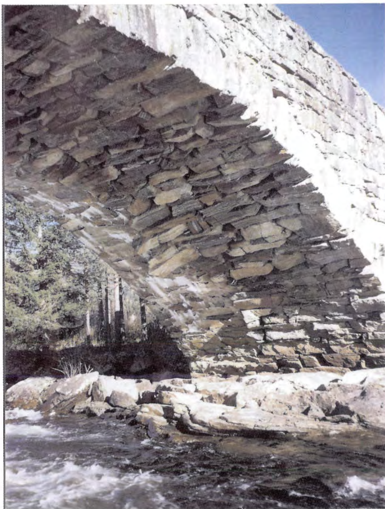
Lunde bru, Oppland. Tørrmurt hvelv med ubearbeidet naturstein. Foto: Per H. Berg.
