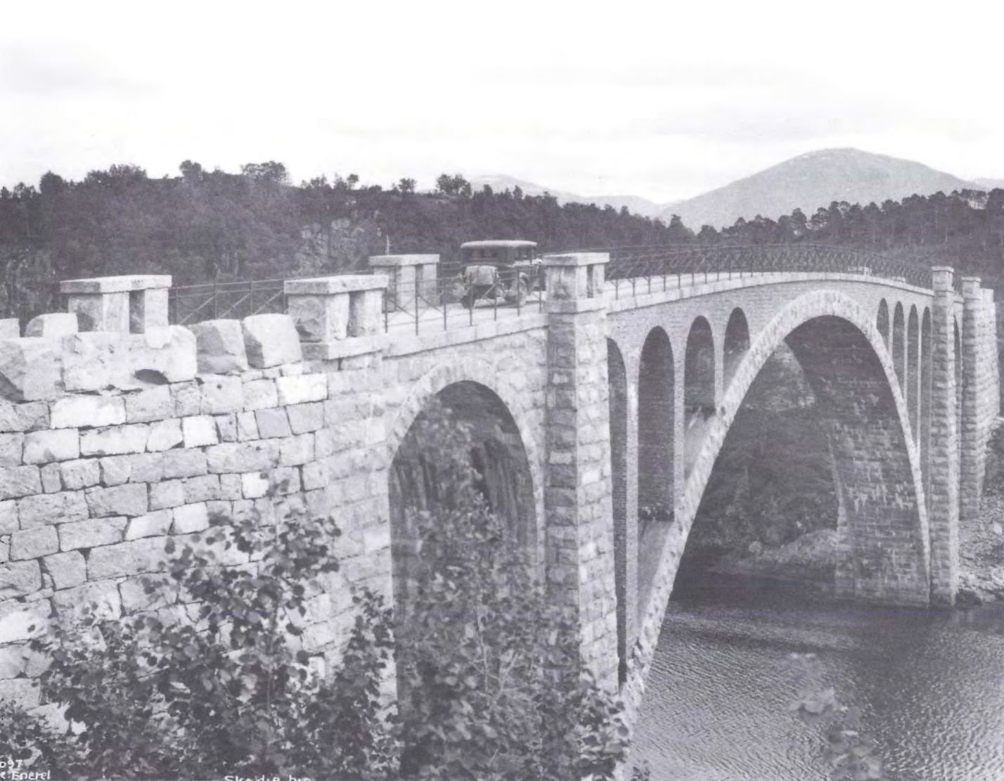
Skodjestraumen bru i Møre og Romsdal, med spennvidde 59 meter. Bygget 1911- 22. Fredet. Foto: Statens vegvesen Møre og Romsdal.
