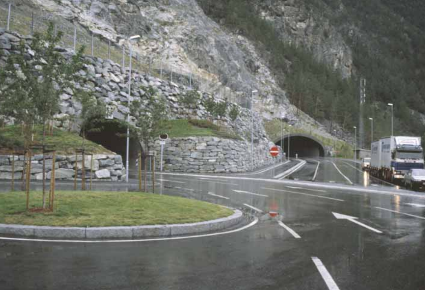
Vakre vegers pris skal stimulere til gode og vakre løsninger. Bildet viser Mannheller fergekai i Sogn og Fjordane. Prosjektet fikk Vakre vegers pris i 1997, en delt pris med gang- sykkelveg langs Hafrsfjord i Rogaland. Mannheller framheves av juryen med en utradisjonell trafikk-løsning for å redusere inngrepene i strandsonen, blant annet med oppstilling i fjellet
