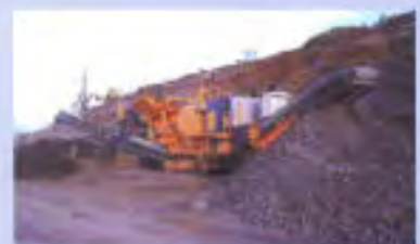
Pukleverk i vegskjæring. (Statens vegvesen)
