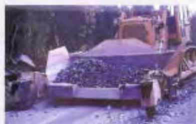
Doser med utlegger. (Statens vegvesen)
