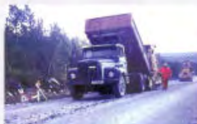
Utlegging, komprimering. (Statens vegvesen)
