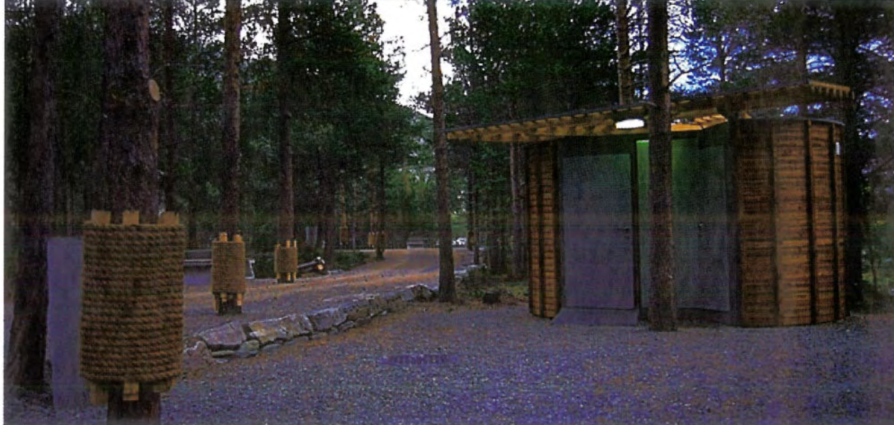
Rasteplassen på Liasanden overvåkes for å kartlegge slitasje. Rv 55, Oppland.
