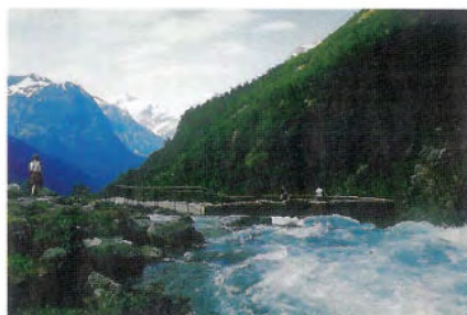
Sikring mot fossen ved Videseter i Sogn og Fjordane.
