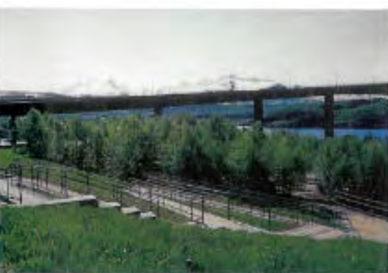
Rullestolrampe ved Saltstraumen Opplevelsessenter. Slike løsninger er svært arealkrevende. Rv 17 i Nordland. Foto: Trine Kanter Zerwekh
