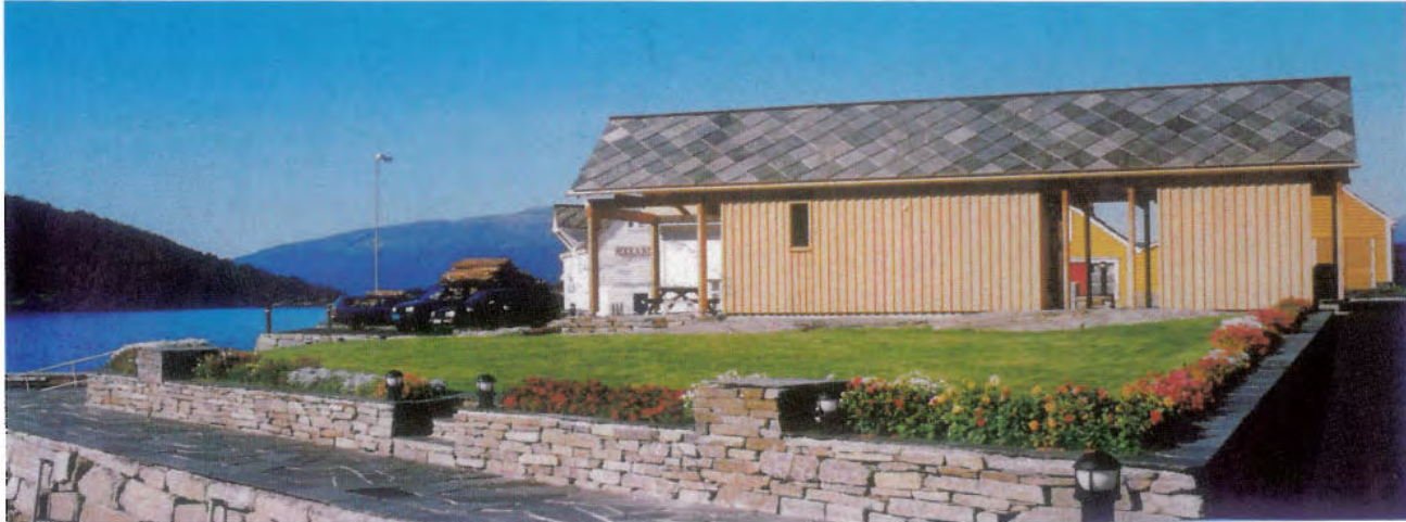
Nytt servicebygg i stedstypisk byggestil i Herand, Rv 550 i Hordaland.
