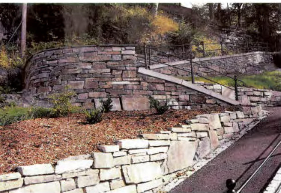
Figur 11.4. Det ble gjort store inngrep i forbindelse med tunnelinnslag for Fløyfjellstunnelen i Bergen. Det ble foretatt nøye registreringer på forhånd. Etterpå ble parken bygget opp igjen med nye materialer i tråd med det opprinnelige kulturmiljøet. Foto: Tone Høyland Stople.
