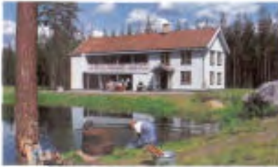
Figur 1.23. Engerodden skyssstasjon var en gang et viktig ledd i et sammenhengende nett av faste skyssstasjoner. Skyssstasjonen lå ved Sperillen langs vegen mellom Ringerike og Valdres og var i bruk som skyssstasjon fra 1866 til 1924. Bygningen spilte også en viktig rolle for lokalsamfunnet ved at den ble brukt til kommunestyremøter. Etter at skyssordningen ble avskaffet i 1924 ble Engerodden bygget om til pensjonat og senere flyttet til Norsk vegmuseum i Øyer på 1980-tallet. Foto: Norsk vegmuseum.
