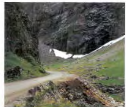
Figur 12.4. Norangsdalen, Møre og Romsdal. Masser fra skråningsarbeider andre steder langs vegen er tipset rett over en gammel natursteinsmur. Begrunnelsen er at vegen er for smal og at det faller is og stein fra fjellet. Et kulturminne fra vegbyggernes egen historie går tapt. Kunne problemet vært løst annerledes? Foto: Anne Trine Hoel.
