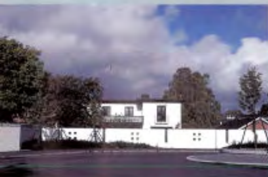
Figur 11.1. St. Croix i Fredrikstad. Støyskjermen er utformet og tilpasset funksisarkitekturen i omkringliggende boliger. Foto: Ulf Haraldsen.
