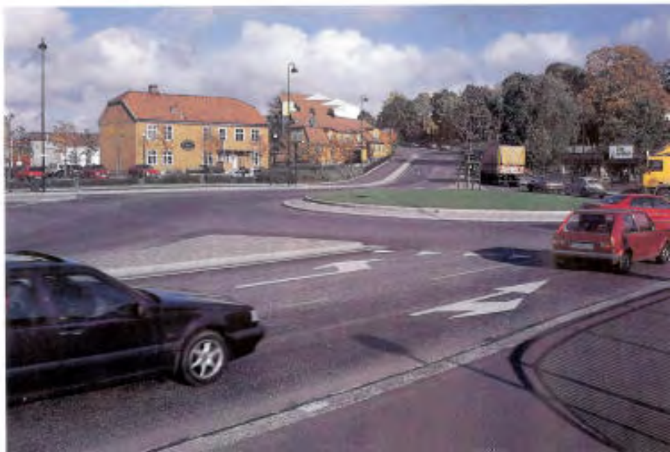
Figur 7.4. Kransen, Moss. Utvidelse av hovedvegen gjennom byen bryter gamle forbindelser og berører verneverdig bebyggelse. Betydelig innsats i detaljer og avbøtende tiltak klarer ikke å dempe virkningen av et for dominerende veganlegg. Foto: Ulf Haraldsen.
