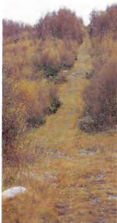
Figur 1.19. Fram til 1850 ble vegene ofte lagt snorrett, uten særlig hensyn til stigning. «Bergenske Hovedvei» over Fillefjell ble bygget som kjøreveg i 1791-92, og en kunne kjøre fra Lærdalsøyri til Østlandet med kjerre. Ved Maristova på Fillefjell, Sogn og Fjordane. Foto: Ulf Haraldsen.
