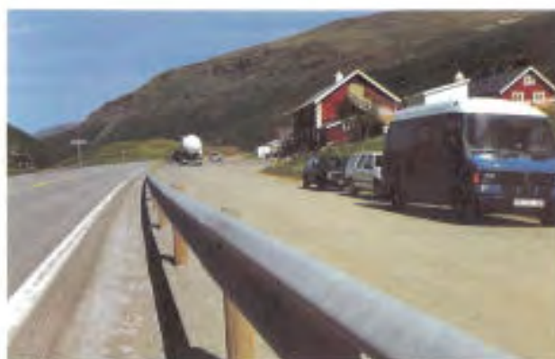
Figur 10.3. E6 Dovrefjell, Sør-Trøndelag. Autovernet er brukt som skille mellom vegen og parkeringsplassen. Det gir en skjæmmende forgrunn til det flotte tunet på Kongsvoll gård. Her har det tidligere vært skystasjon. Foto: Amund Vik.
