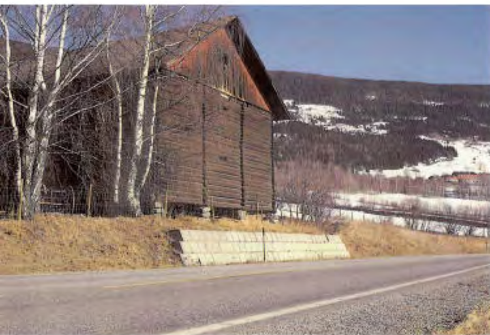
Figur 11.3. E 6 Gudbrandsdalen, Oppland. Vegen ligger for nær opptil den gamle bebyggelsen. Betongblokkmuren passer svært dårlig til bebyggelsen og forringer kulturmiljøet ytterligere. Ved bruk av naturstein ville resultatet blitt bedre. Foto: Amund Vik.
