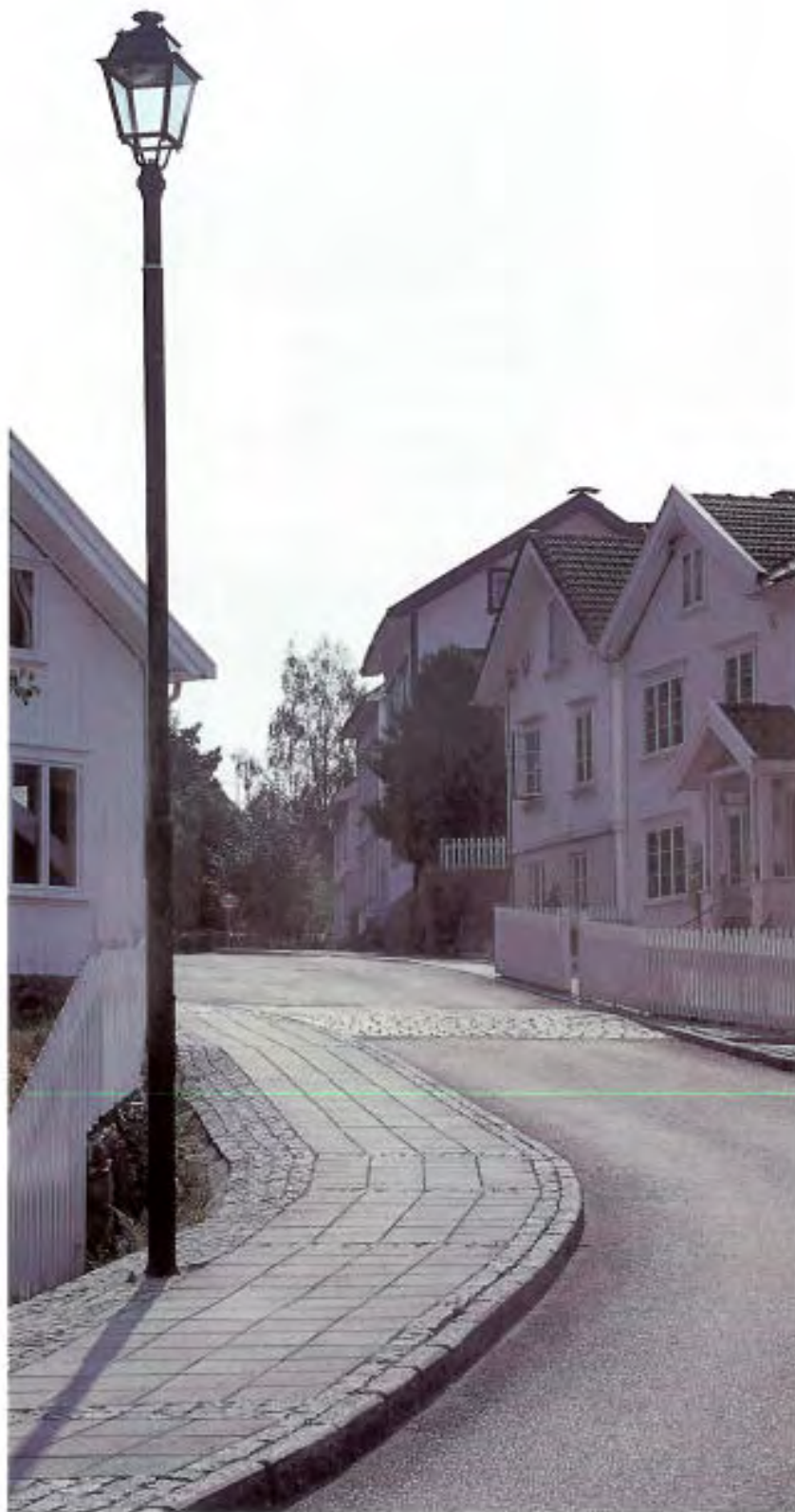
Figur 8.5. Rv 410 Tvedestrand i Aust-Agder. Innfarten til Tvedestrand fra syd går gjennom et verdifullt trehusmiljø. Dette partiet er for trangt til å romme to kjørefelt og fortau. For å unngå riving, er riksvegen innsnevret til ett felt. Foto: Ulf Haraldsen.
