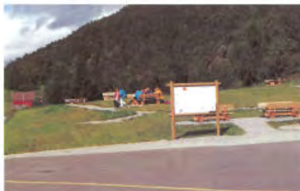
Figur 10.4. E6 Drivdalen, Sør-Trøndelag. I tillegg til sin primære funksjon er også denne rasteplassen et godt utgangspunkt for å kunne oppleve det gamle veganlegget ved Vårstigen til fots. Det er tilrettelagt for dette gjennom informasjonstavler og undergang under E6. Foto: Gunnar Tørud.
